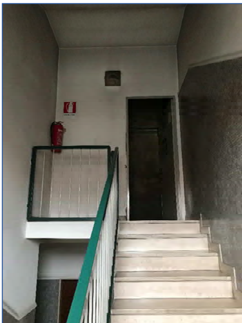
Foto 35 - vano scala comune accesso piano sottotetto
