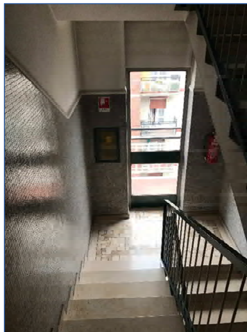
Foto 8 - vano scala comune
