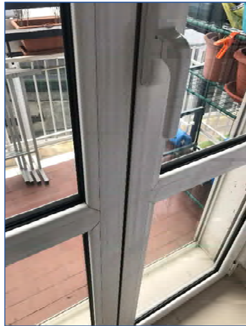
Foto 30 - dettaglio serramenti esterni
