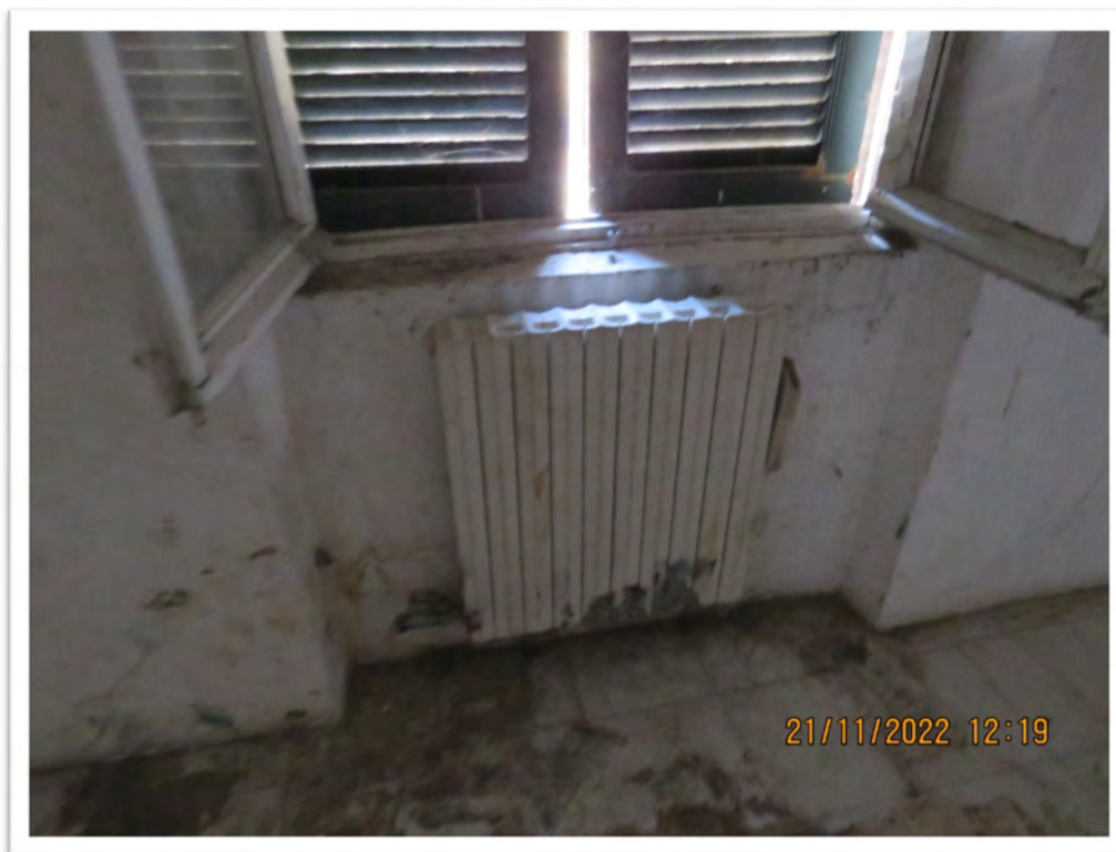
Particolari del serramento e del termosifone e della scala che conduce al piano superiore in cui sono ubicati i solai.
