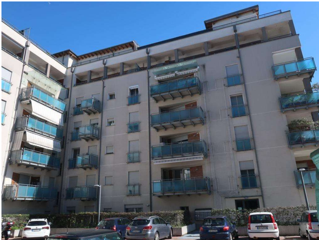
FACCIATA SU CORTILE INTERNO
