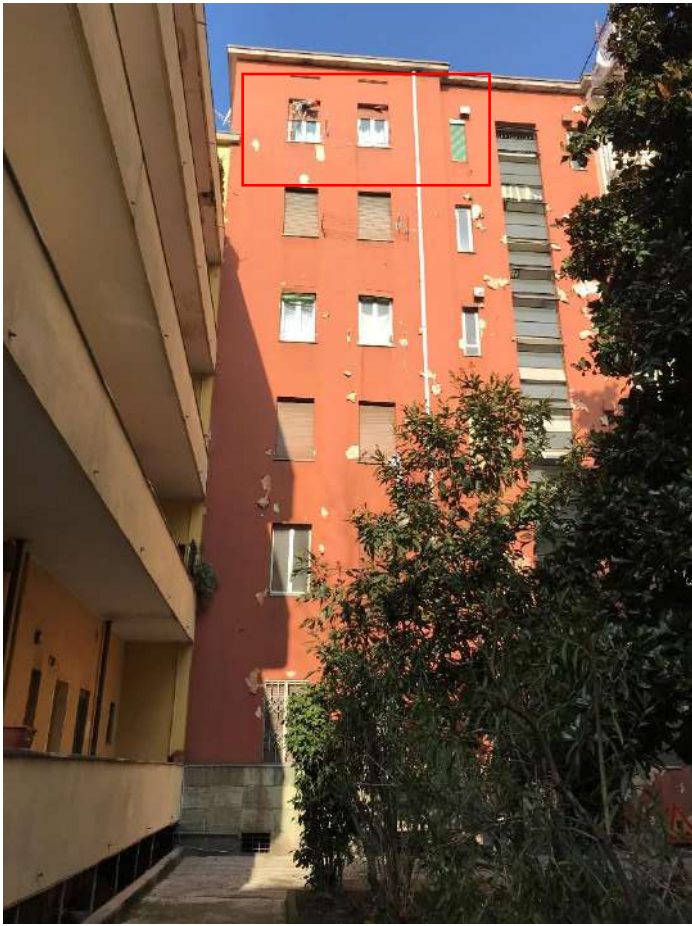
Facciata su cortile
