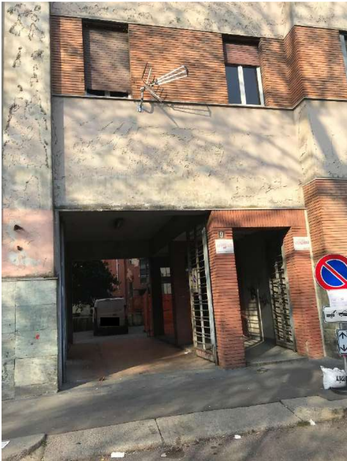
Ingresso dal civico 9 di Via Mar Jonio
