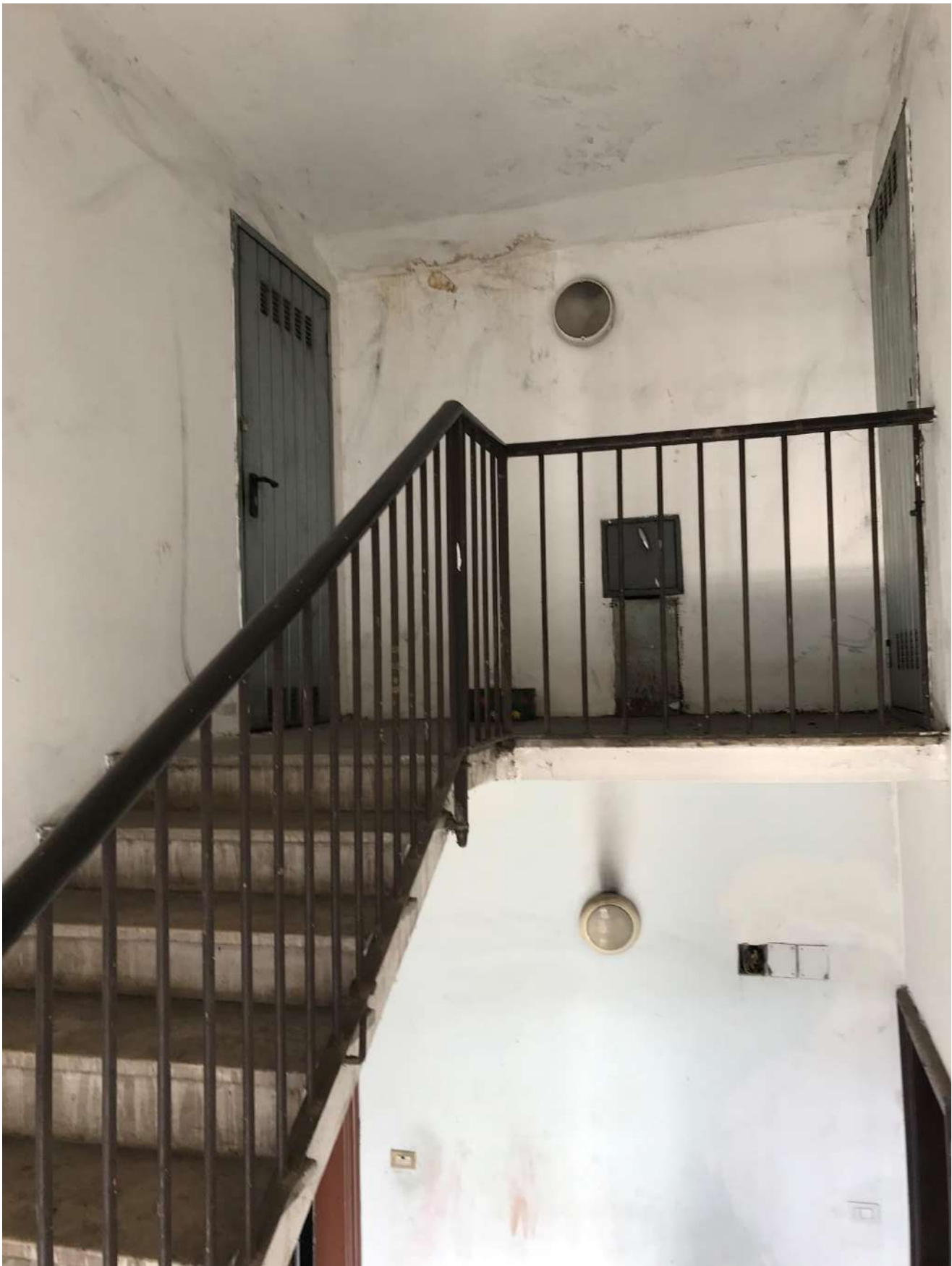
Porta ingresso al solaio non accessibile
