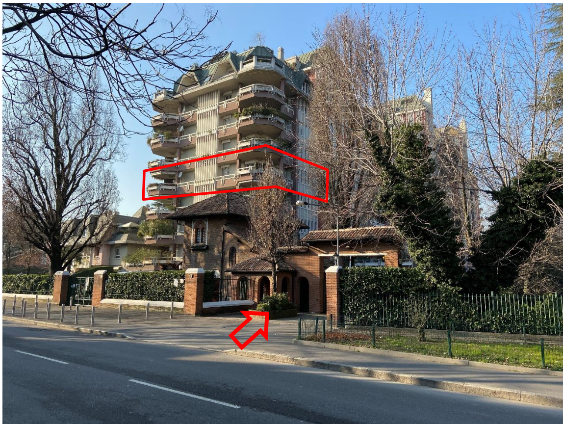
Viste del fabbricato
