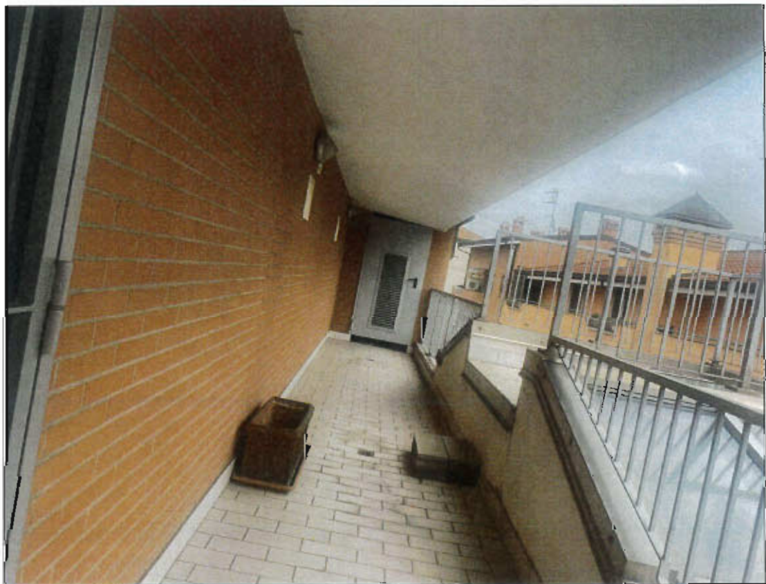
BALCONE LOCALI DI SGOMBERO
