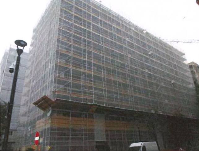
Il fabbricato in riqualificazione (V. Cimarosa, V. Mozard)
