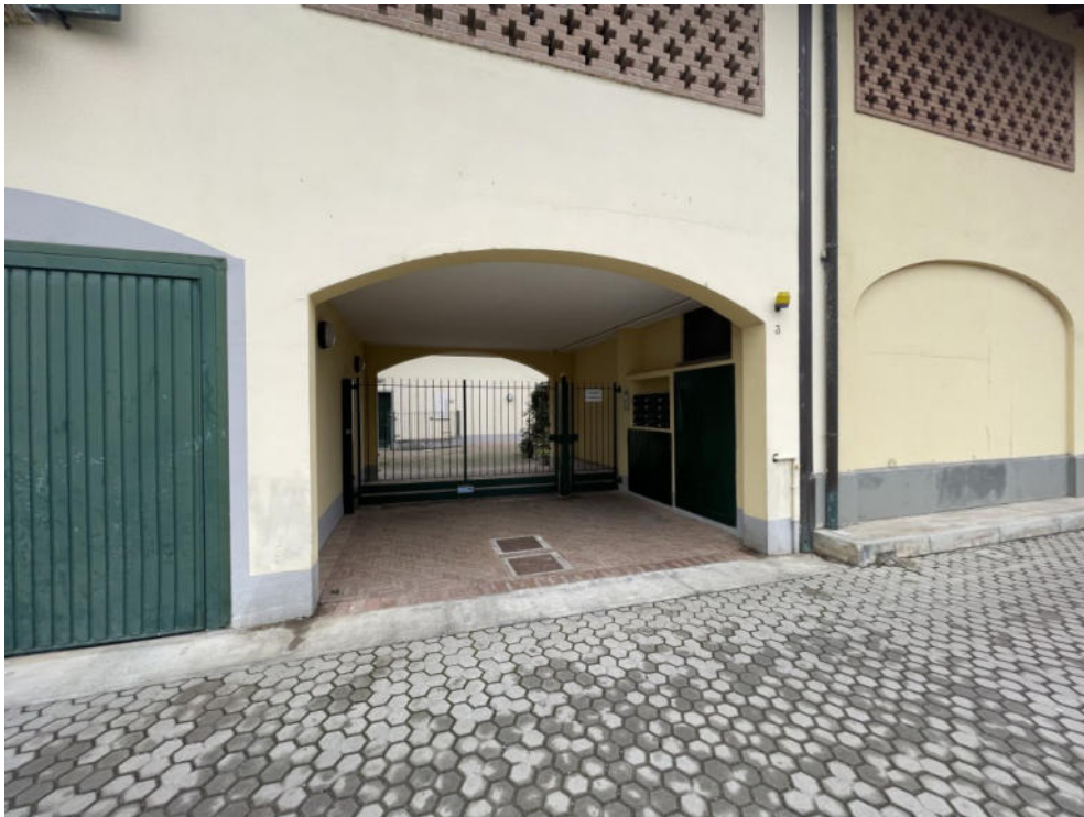
FOTO 1: SETTALA, CASCINA CASTELLETO SNC, ingresso condominiale
