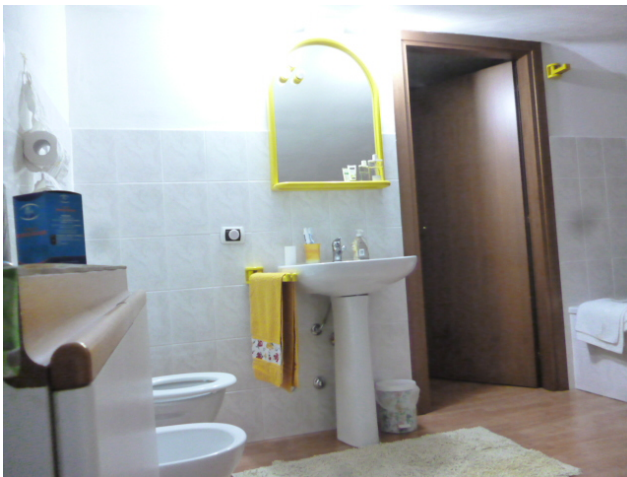
FOTO 16 – Particolare bagno piano sottotetto
