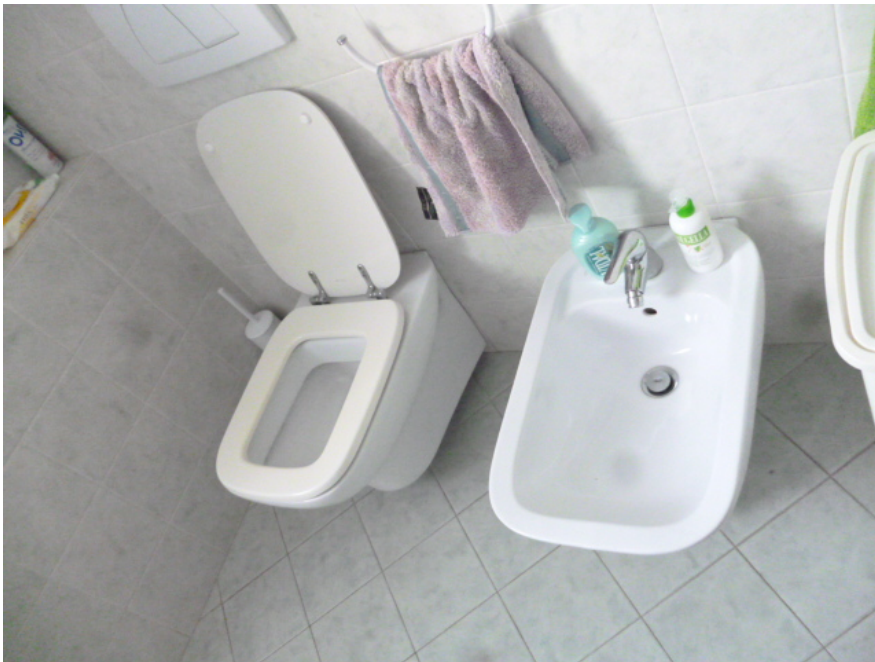
FOTO 12 – Sanitari e rivestimento dei bagni
