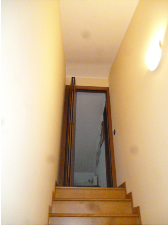
FOTO 13 – Vano scala al piano sottotetto con porta interna di divisione SUB. 707
