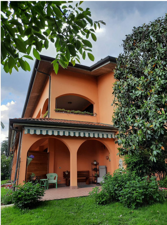
FOTO 4 – Area esterna Sub. 707
