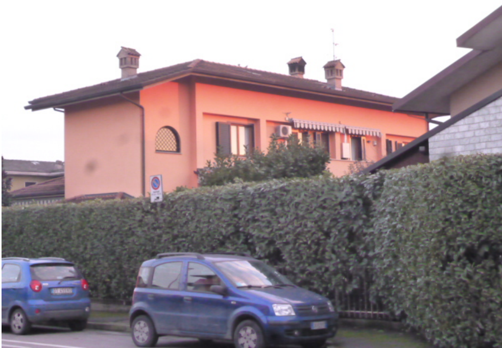
FOTO 1 e 2 – L'edificio di Viale della Resistenza n° 3 in Truccazzano
