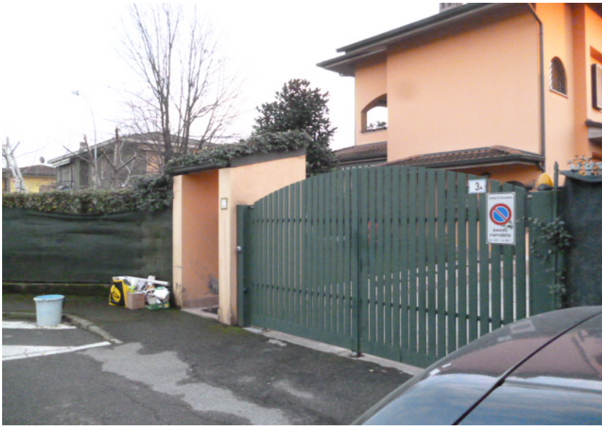
FOTO 3 – Accessi pedonale e carraio automatizzato
