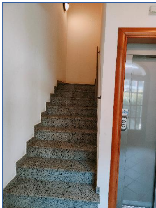
Foto 8 - vano scala comune
