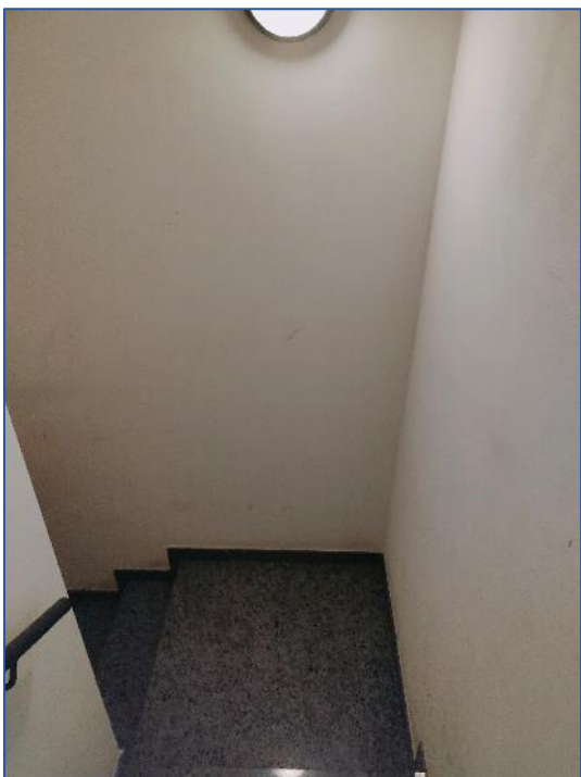
Foto 9 - vano scala comune
