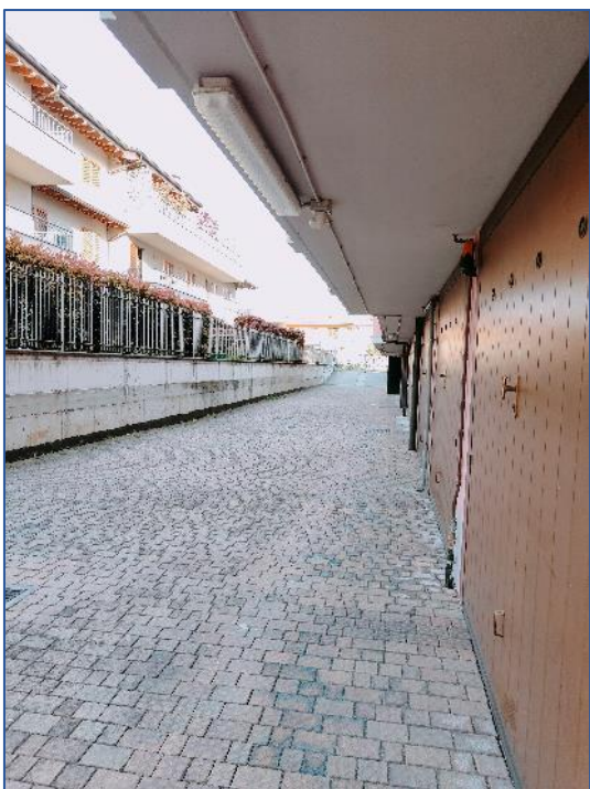
Foto 11 - spazi di manovra comuni
