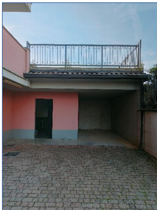
Foto 12 - spazi di manovra comuni
