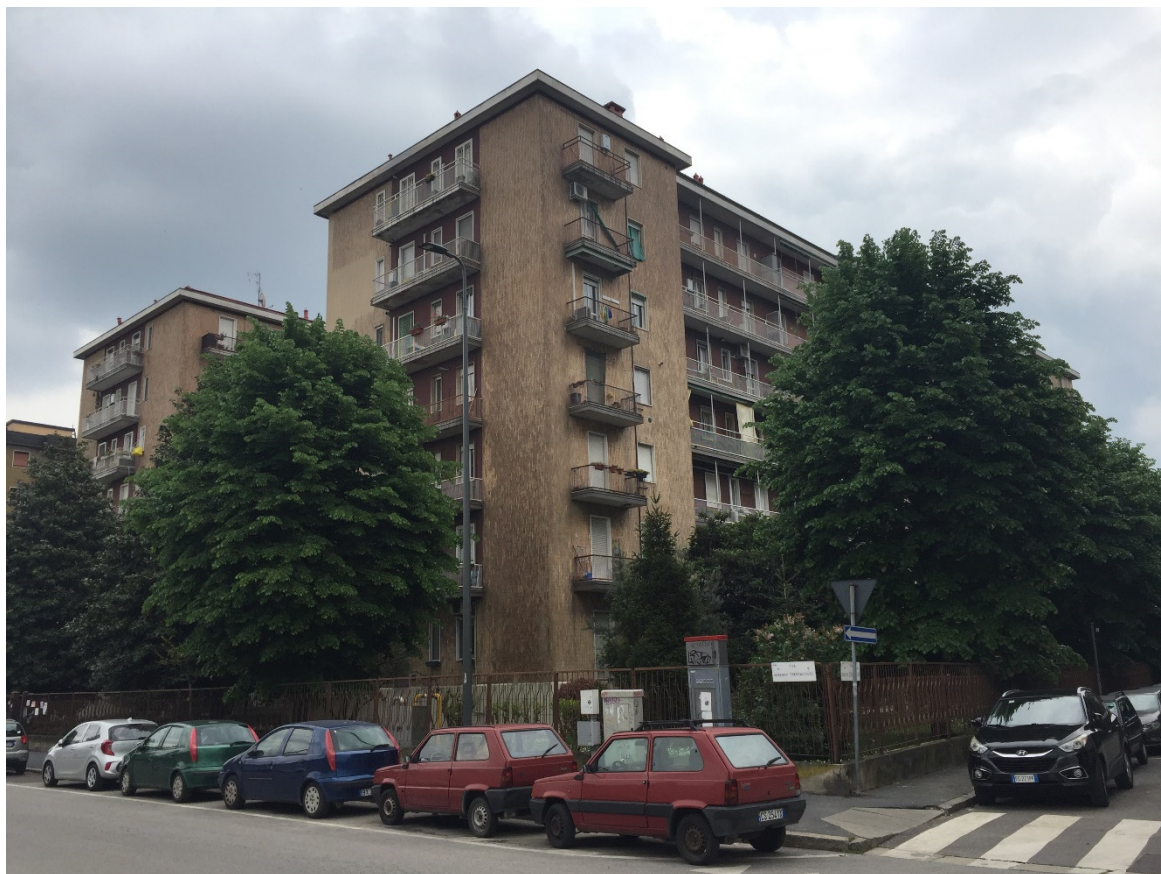
Foto 01 - Il fabbricato su via Domenico Trentacoste
