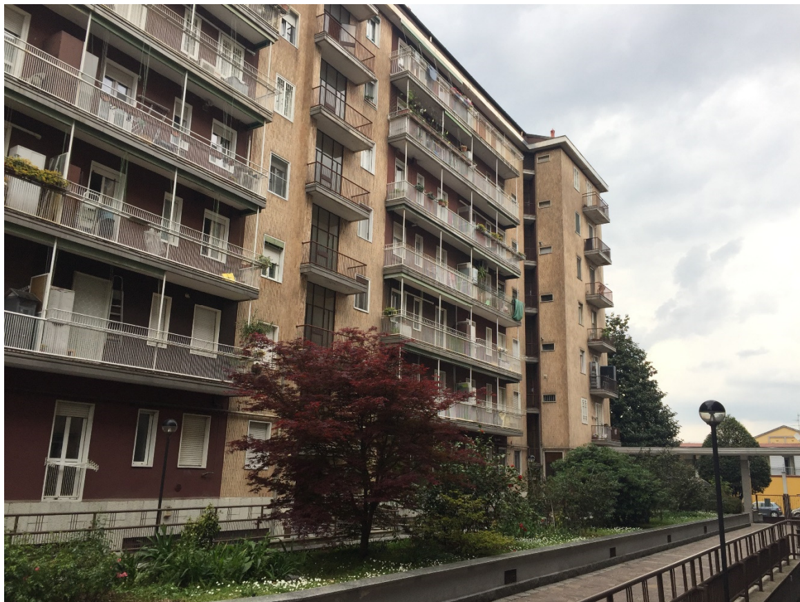
Foto 03 - Il fabbricato sul cortile interno
