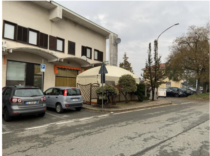
2_ prospetto lato est (Via Gorizia)
