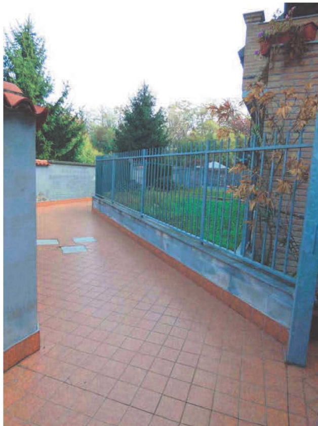
Foto 4. Percorso pedonale per raggiungere il vano scale
