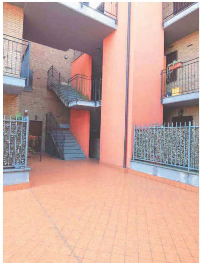
Foto 10. Sbarco vano scale e ascensore al piano terra
