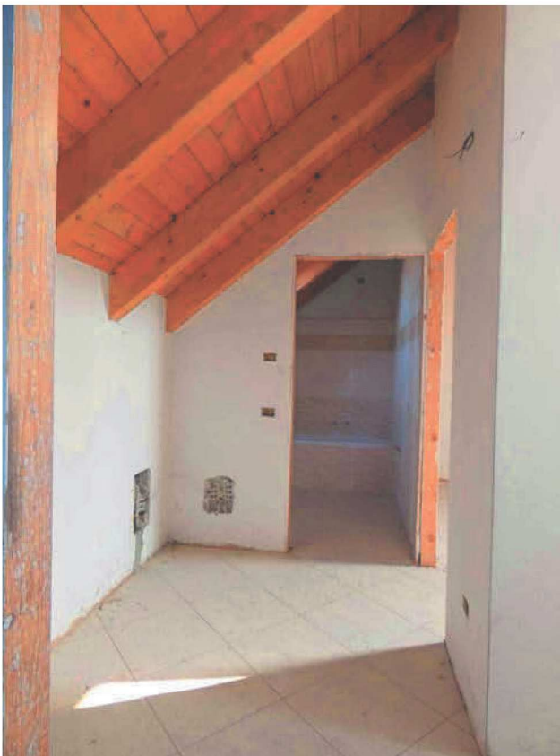
Foto 23. Disimpegno al piano terzo sottotetto
