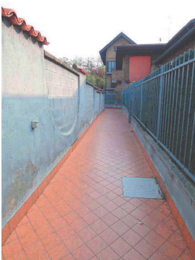
Foto 3. Percorso pedonale per raggiungere il vano scale
