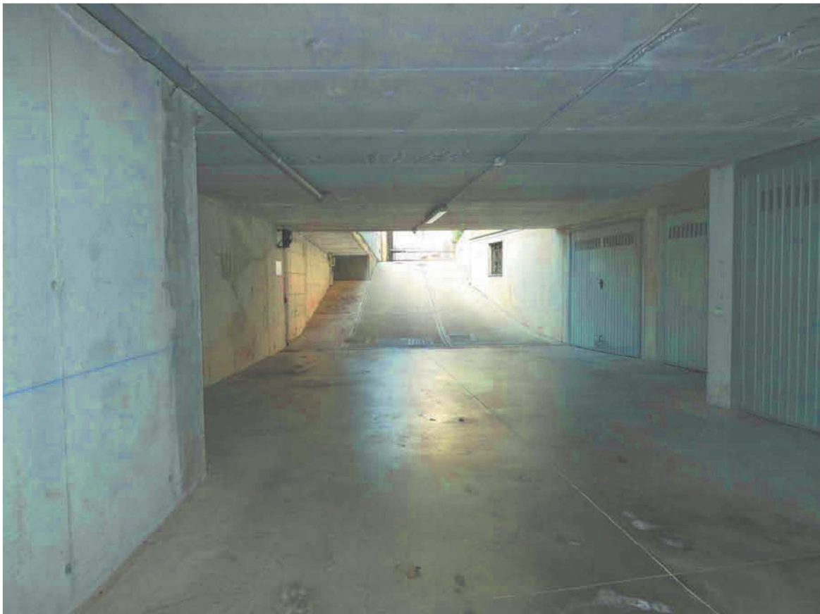
Foto 12. Rampa d'accesso ai box
