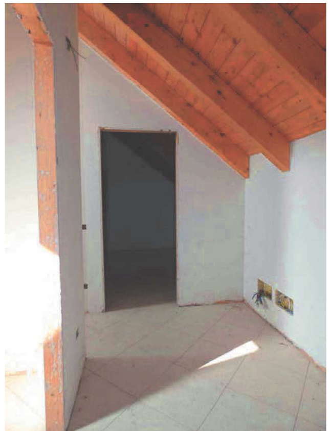
Foto 24. Disimpegno al piano terzo sottotetto
