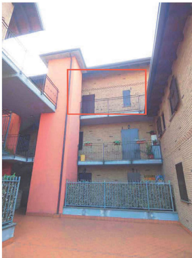
Foto 6. Prospetto su cortile lato nord
