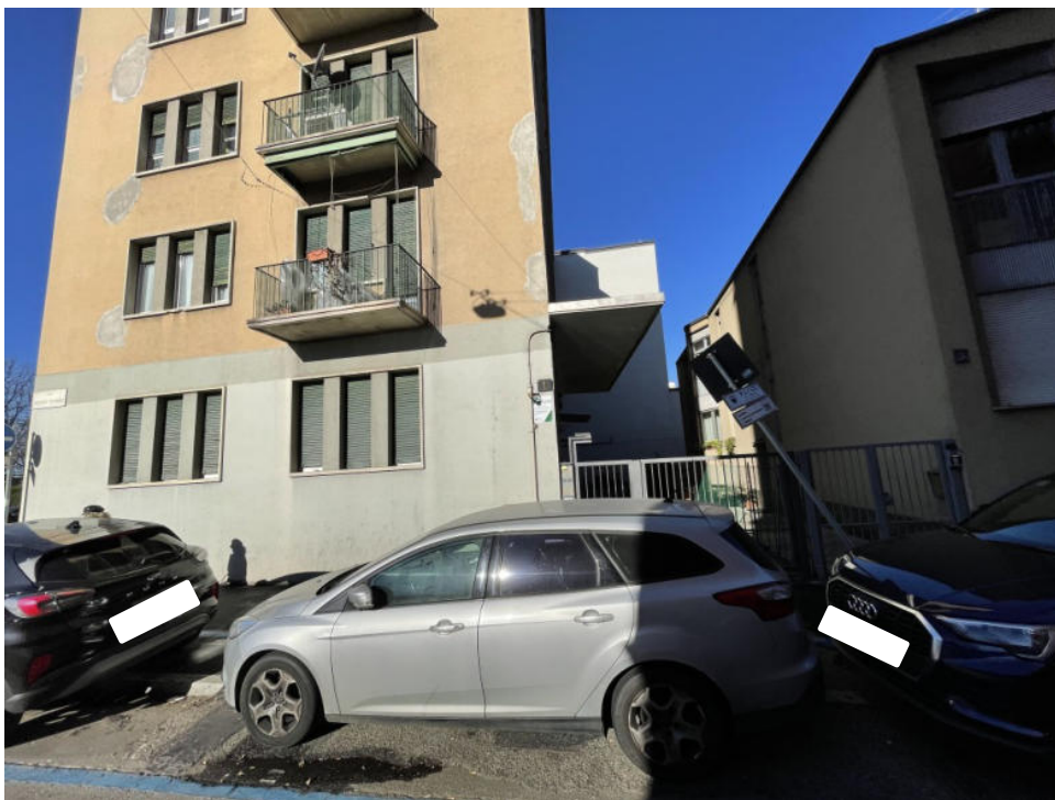
FOTO 1: MILANO, VIA MONTE POPERA 1, ingresso da via Monte Popera 1
