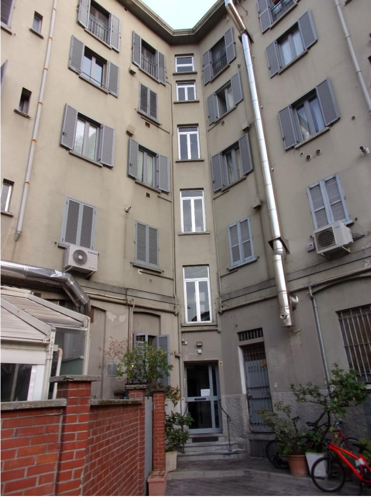
Foto 2: esterno ingresso scala nel cortile interno
