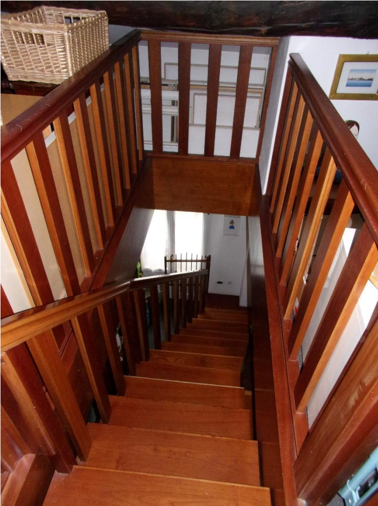
Foto 15: scala di collegamento con piano superiore, vista dall'alto
