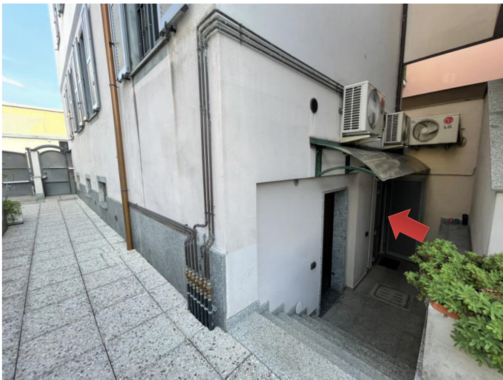
FOTO 2: MILANO, VIA GARDONE 21, ingresso immobile
