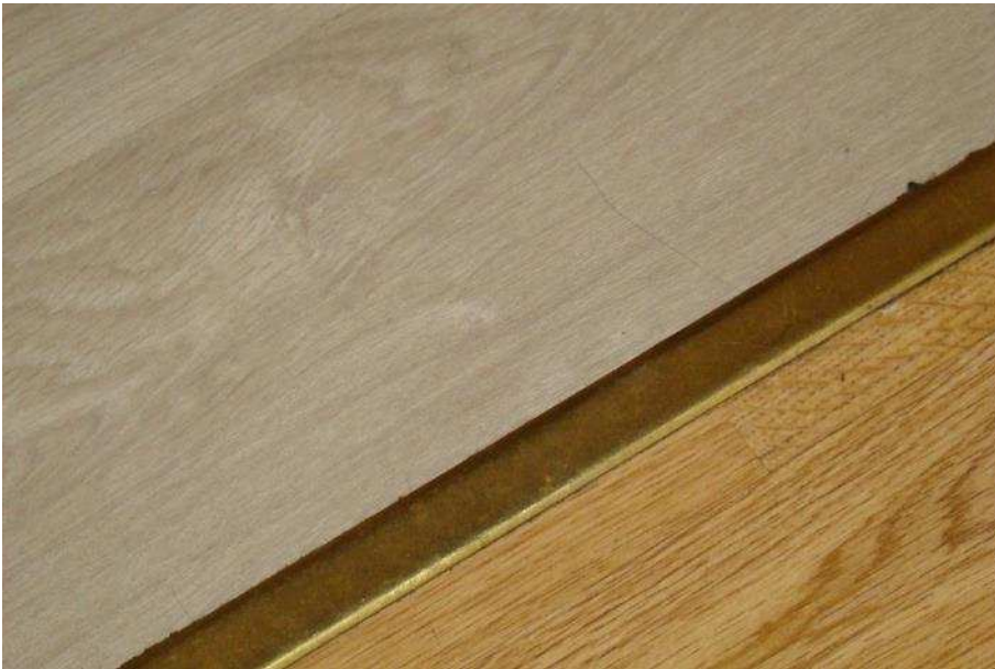
18. Dettaglio del pavimento.
