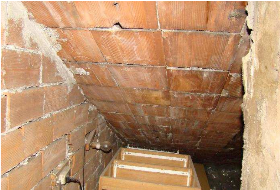
22. Vista interna del solaio.
