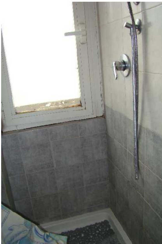
20. Dettaglio del serramento in pvc.
