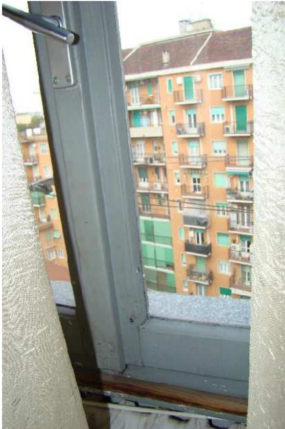
19. Dettaglio del serramento in legno.
