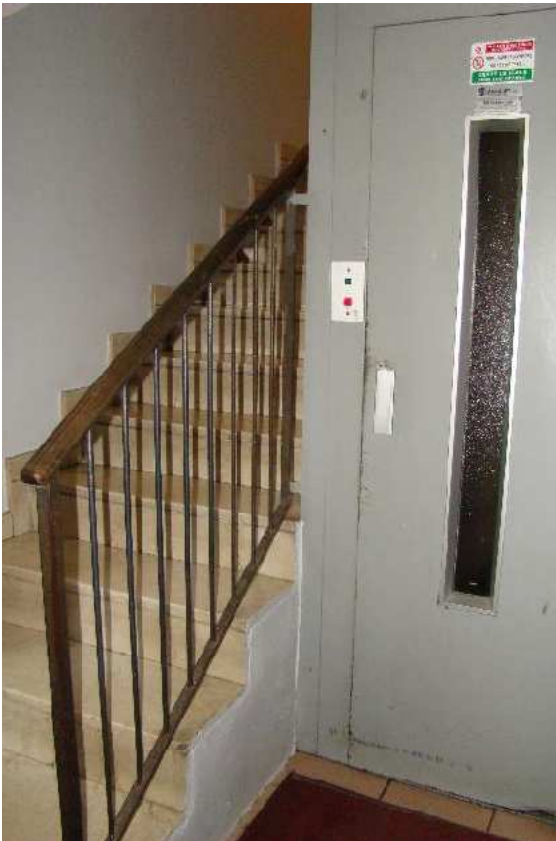
6. Dettaglio delle scale e dell'ascensore comune.
