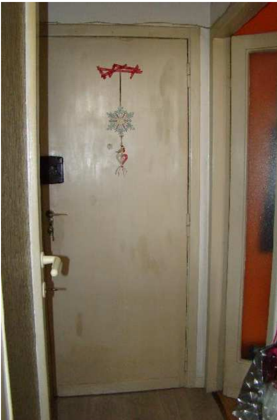
8. Dettaglio della porta di accesso all'alloggio dall'interno.
