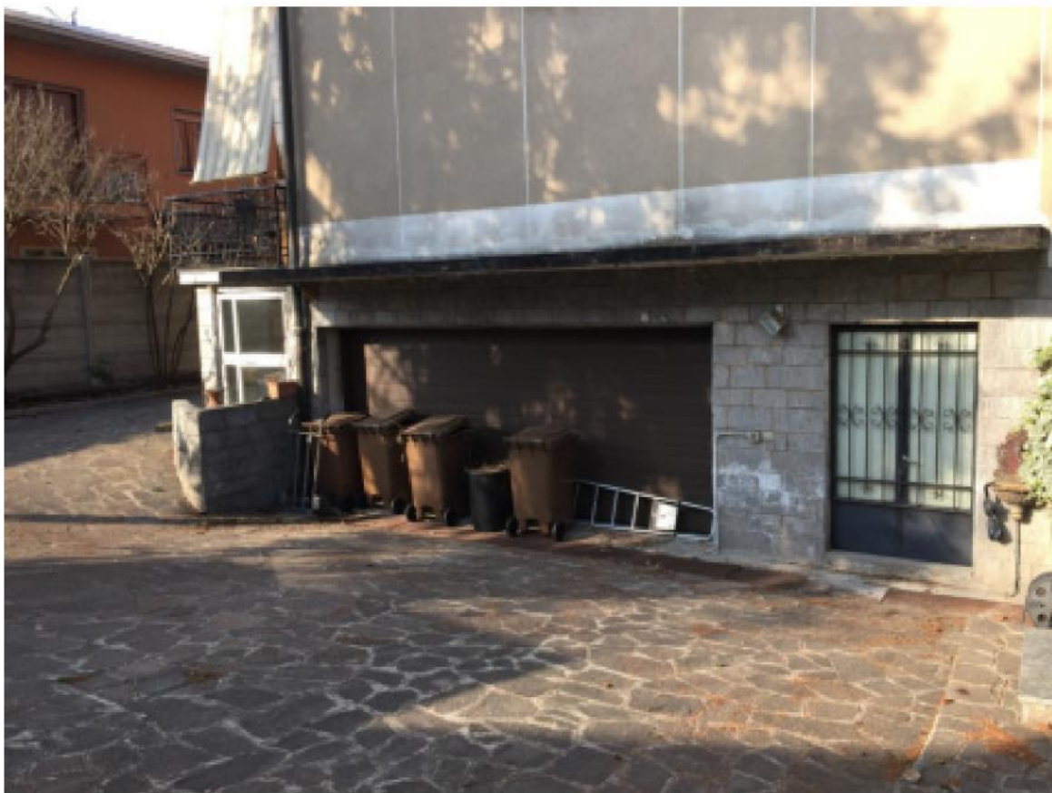
Foto 34 - Accesso al box doppio
