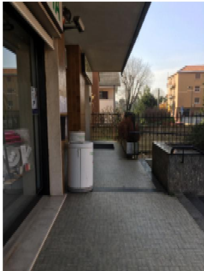
Foto 08 - Terrazza di accesso all'unità
