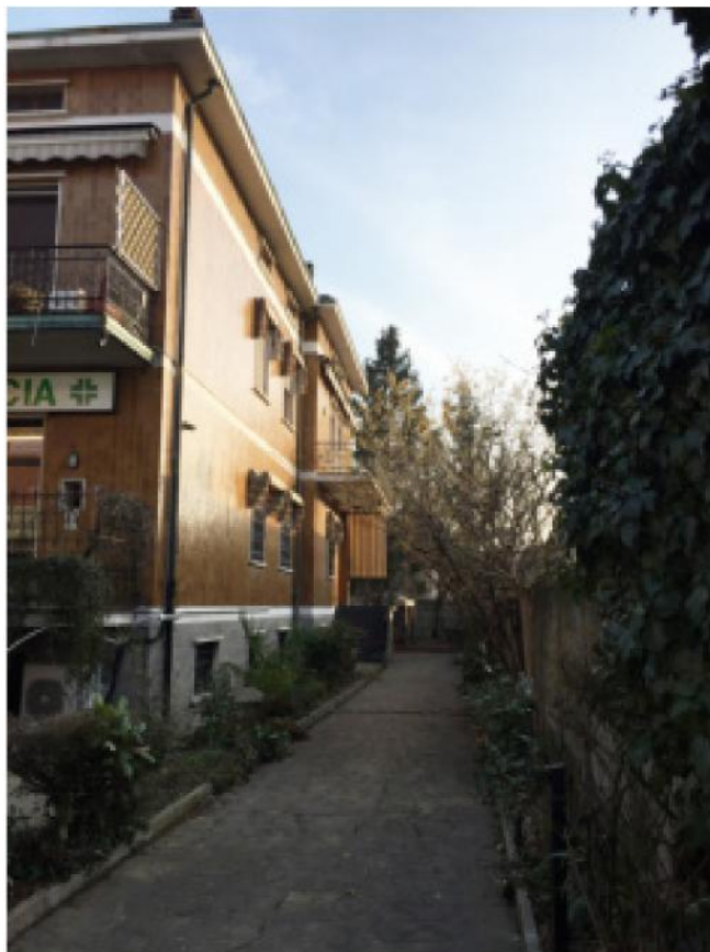
Foto 05 - Vialetto interno laterale del fabbricato
