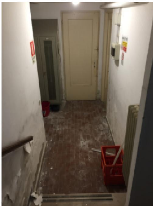
Foto 28 - Disimpegno al primo piano interrato
