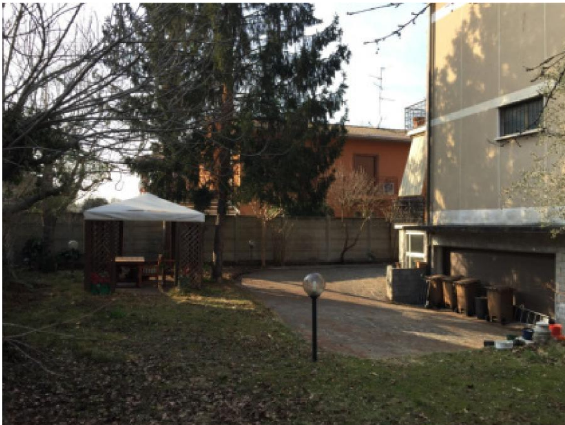
Foto 33 - Il retro del fabbricato con il giardino
