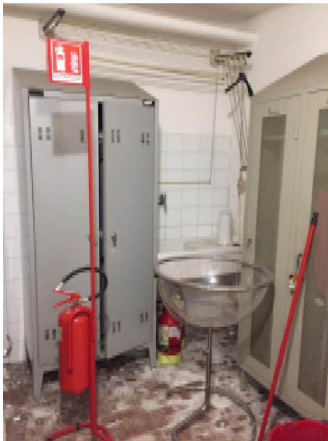
Foto 29 - Disimpegno al primo piano interrato
