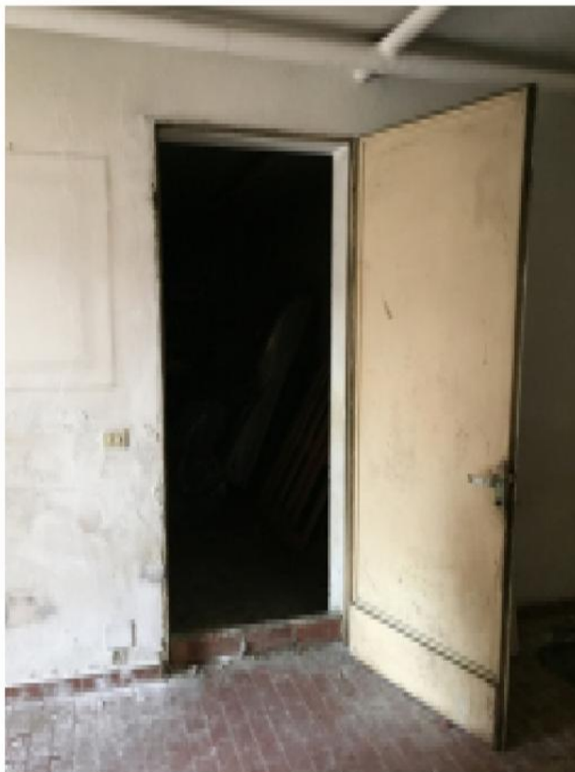
Foto 40 - Accesso al box dal corridoio al primo piano interrato
