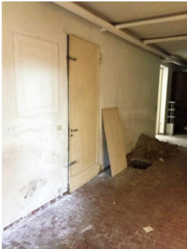
Foto 39 - Accesso al box dal corridoio al primo piano interrato
