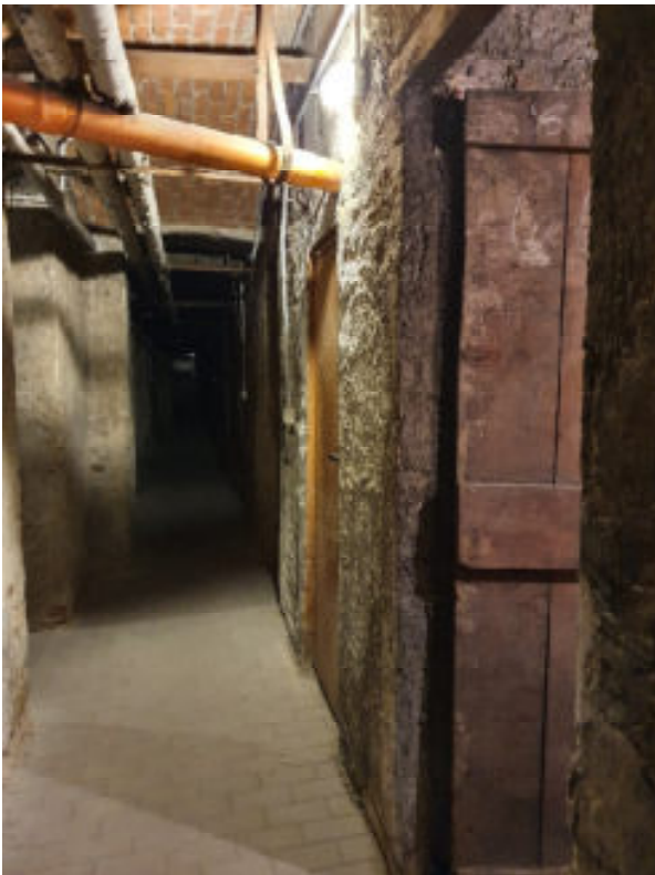
VISTA DEL CORRIDOIO CANTINE
