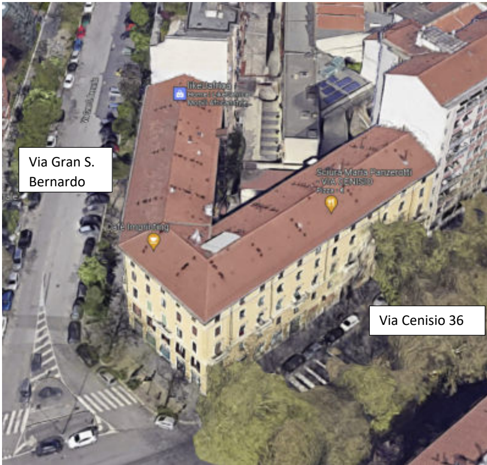
VISTA DEL FABBRICATO
