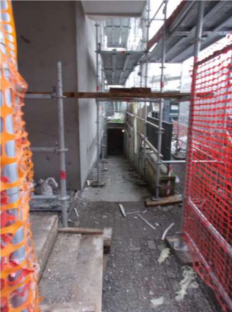
Foto 14: accesso piano cantina dal cortile
