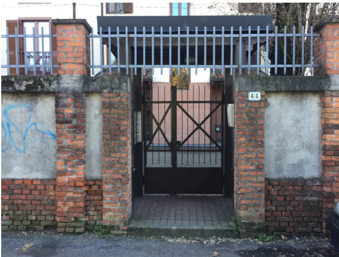
Foto 04 - Accesso al fabbricato su via Dante Alighieri al civico 4/A
