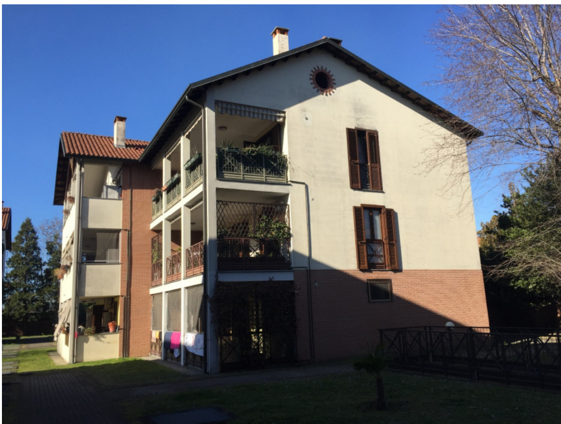
Foto 06 - Il fabbricato nel giardino interno comune (fronte est)
