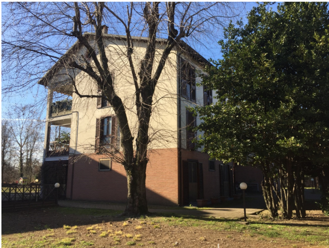
Foto 05 - Il fabbricato nel giardino interno comune (fronte est)
