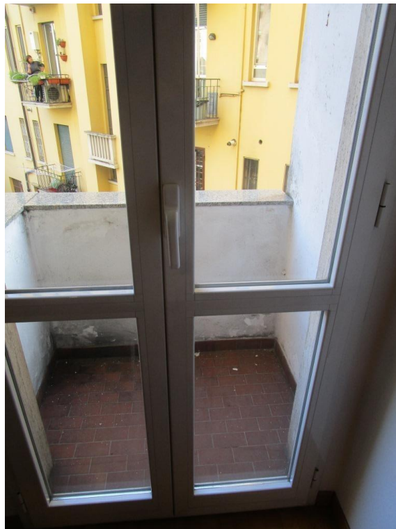
Foto 17 – Balcone camera da letto
