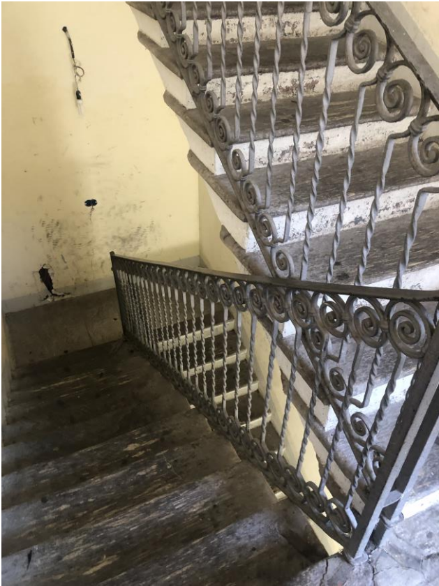
Vista vano scala comune
