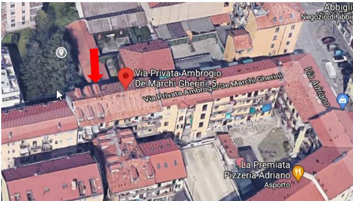
Vista assonometrica del fabbricato da Google Maps
