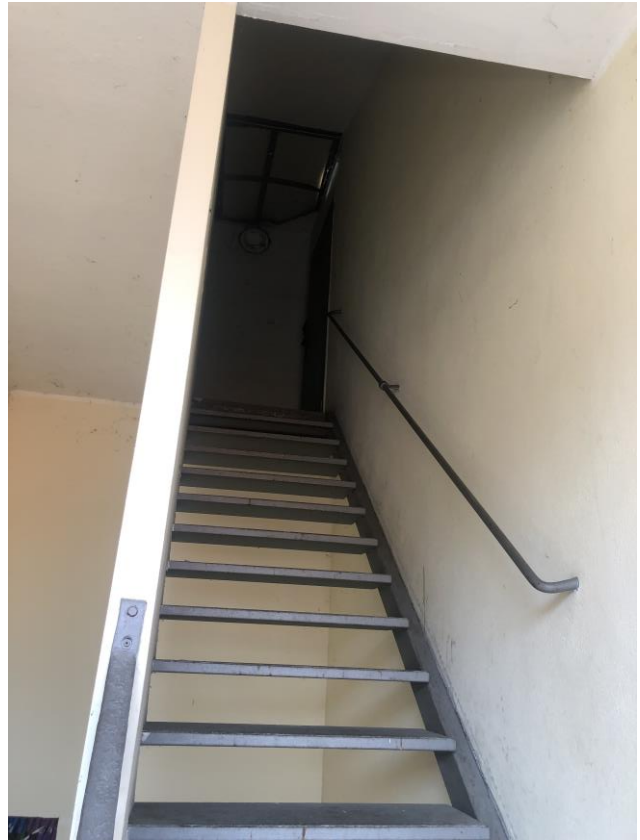
Vista vano scala al piano sottotetto
