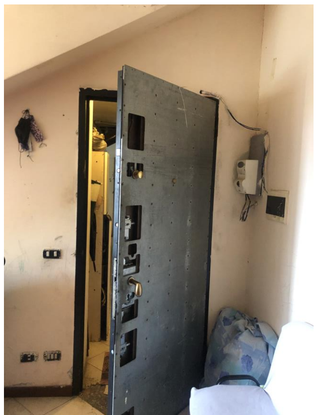
Vista porta di ingresso dall'interno
