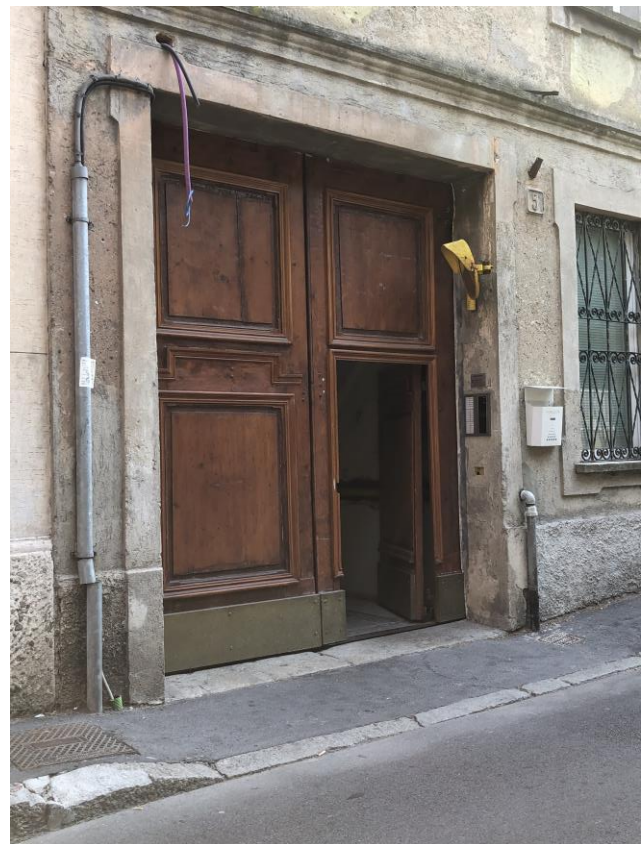
Viste ingresso al fabbricato
