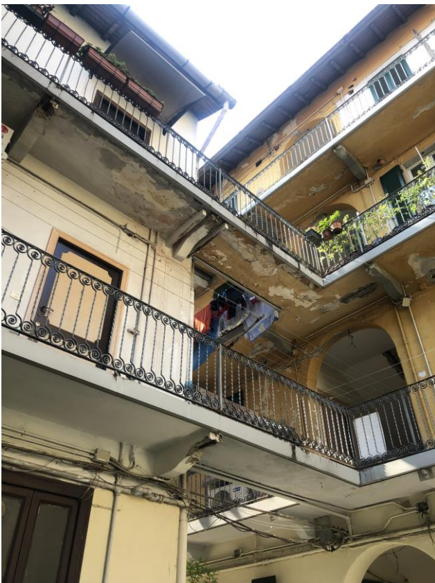
Vista del fabbricato dagli spazi comuni
