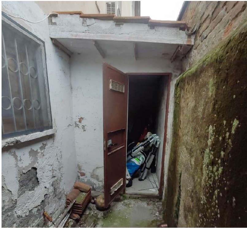
Foto n. 7 – Ingresso al ripostiglio esterno
