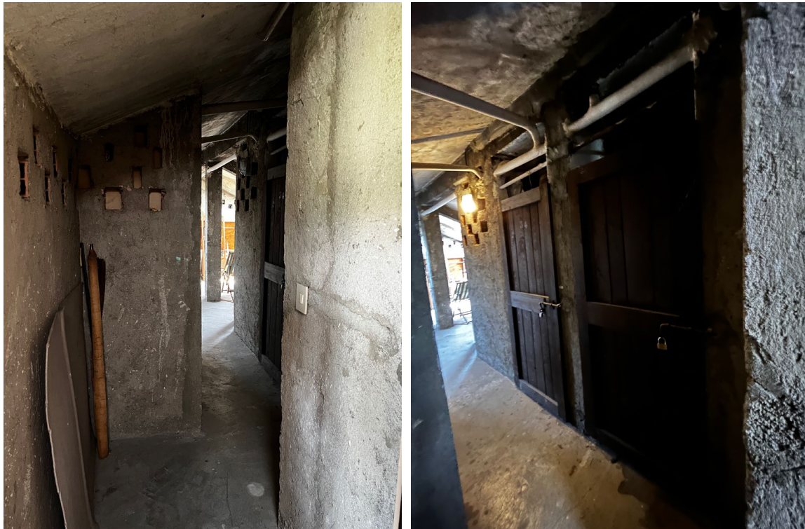
Immagini 27 e 28. Il corridoio di accesso al sottotetto e il portoncino di accesso inquadrato dall'esterno.
