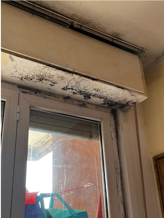
Immagini 12 e 13 . Dettaglio del serramento della cucina, con tracce di umidità e presenza di muffe e della collocazione della caldaia.
