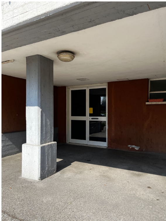
Immagine 3 . il Portico sotto il quale è collocato il portoncino di accesso al fabbricato.
