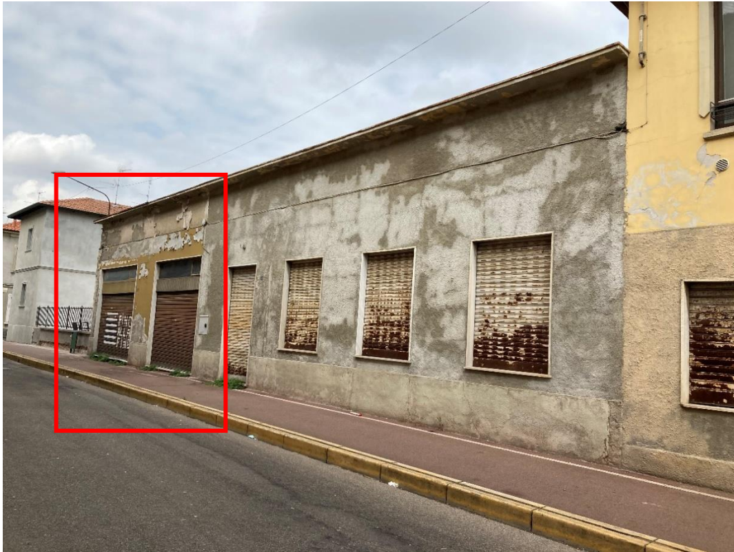
Foto n. 1: Prospetto principale su Via XXIV Maggio
