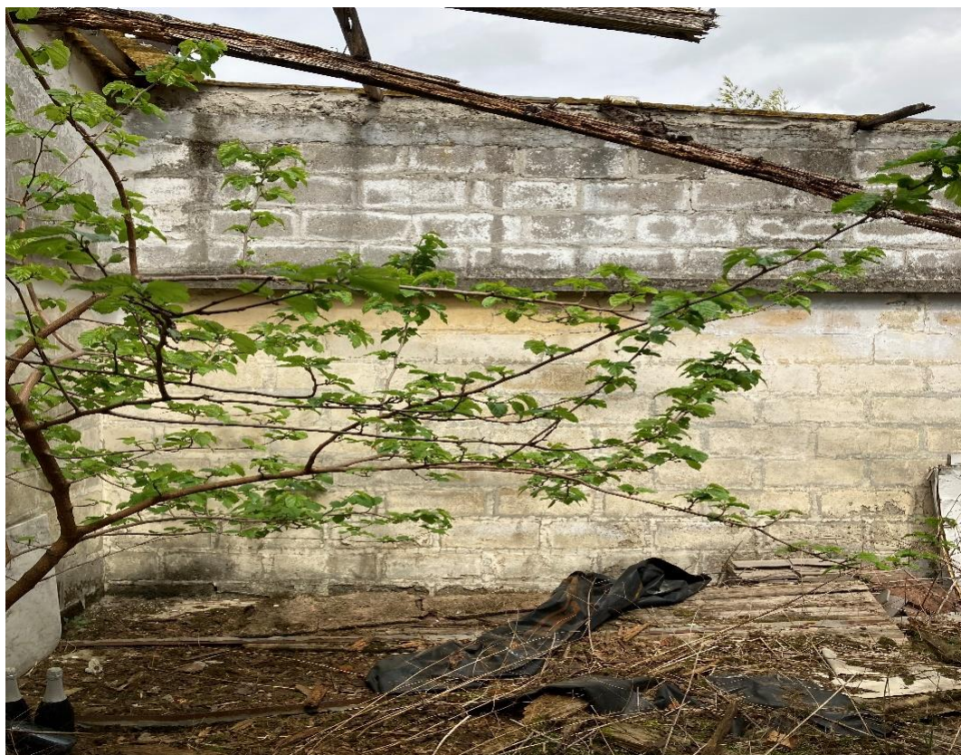
Foto n.12: ulteriore angolazione locale deposito.
