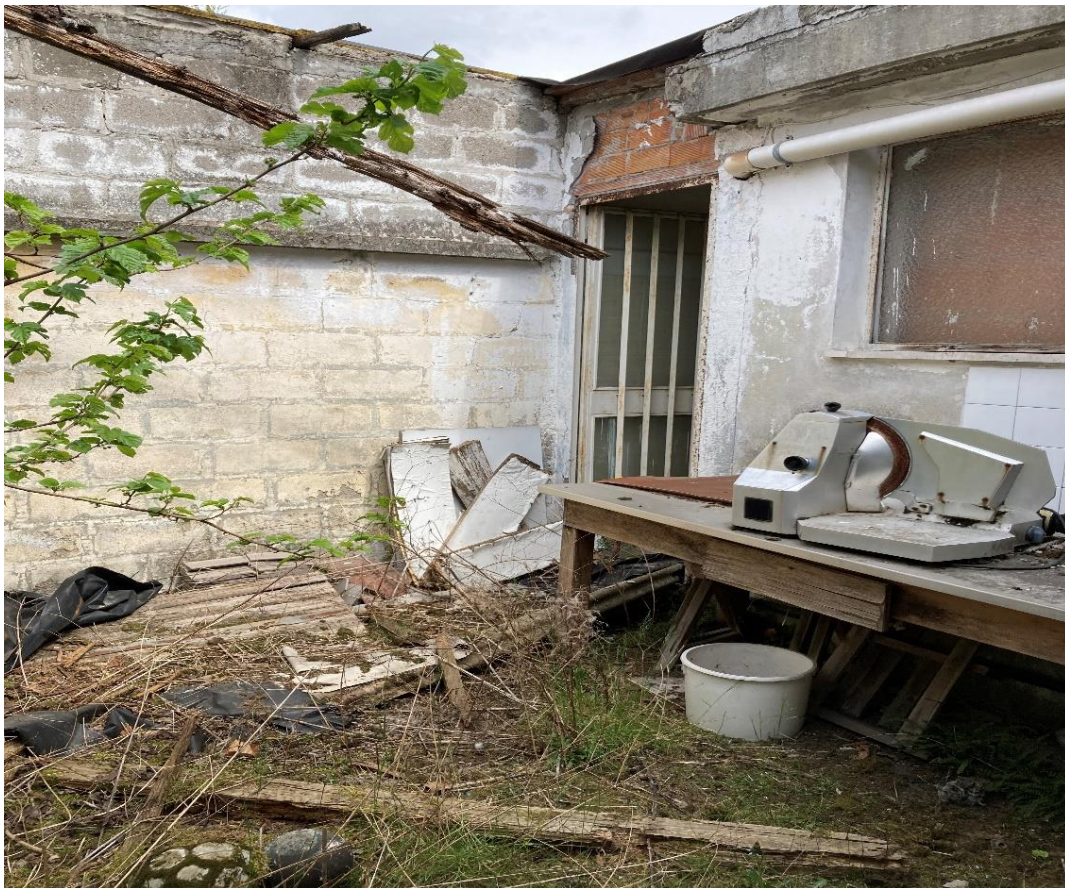
Foto n. 10: altra visuale deposito.
