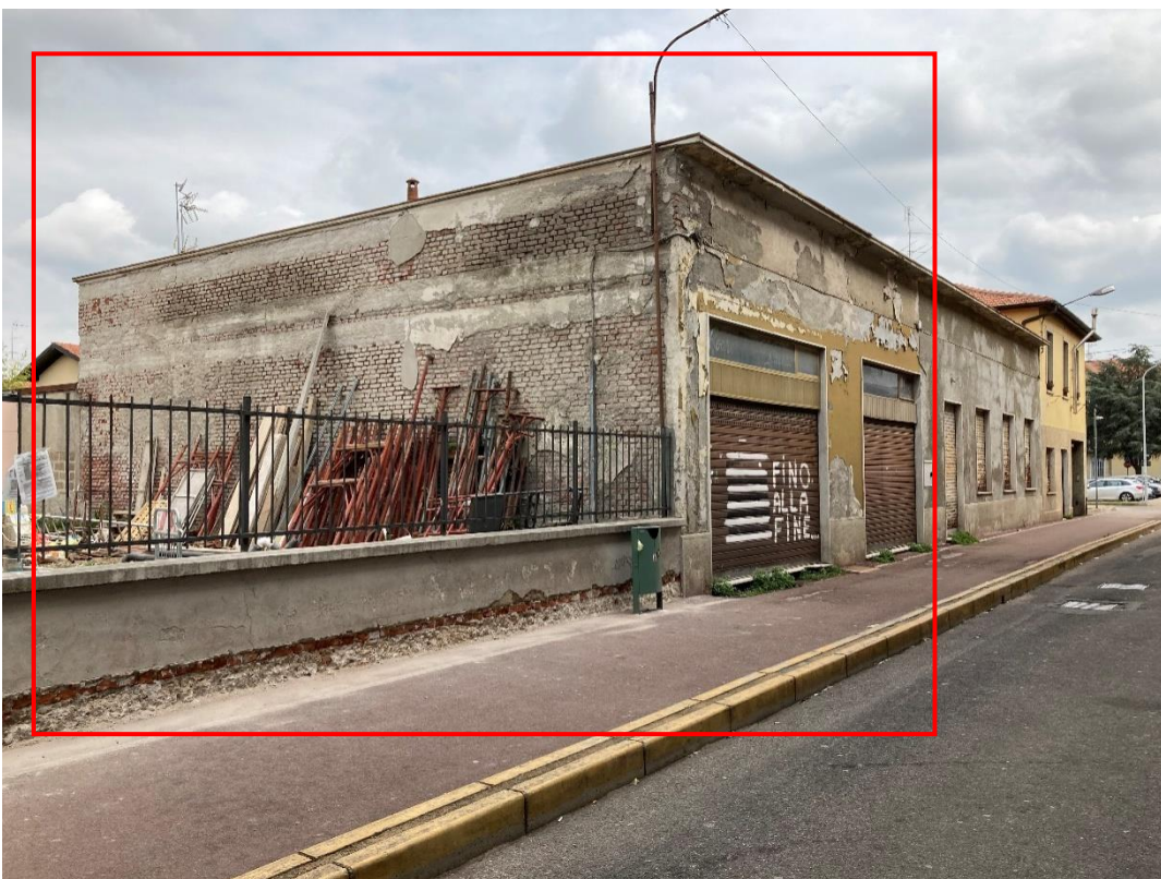
Foto n. 2: ulteriore vista prospetto su Via XXIV Maggio
