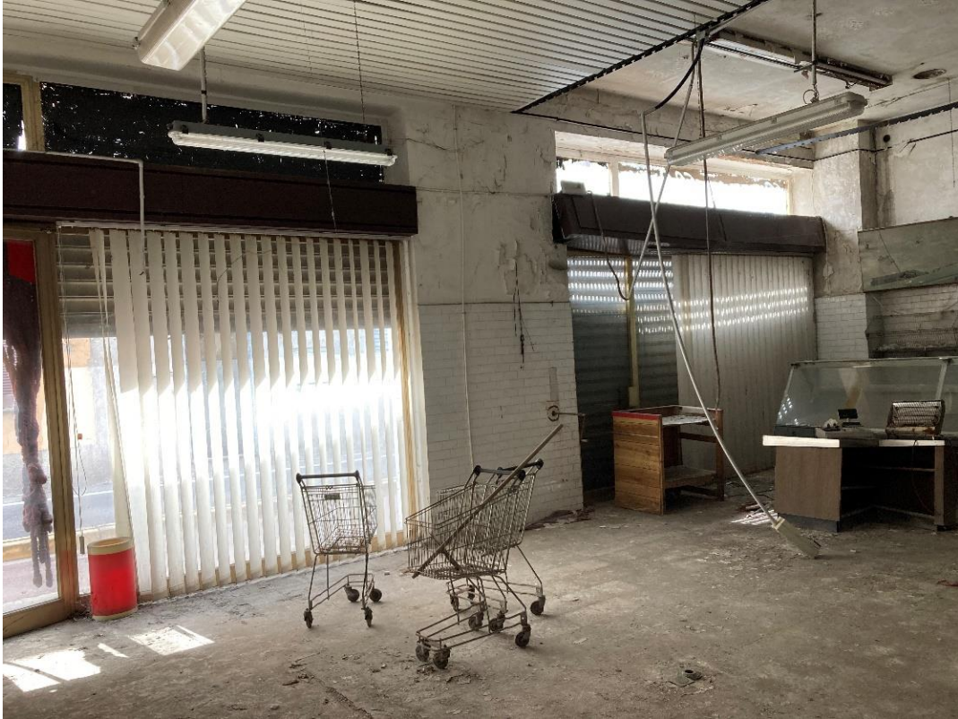
Foto n. 3: Interno locale principale.
