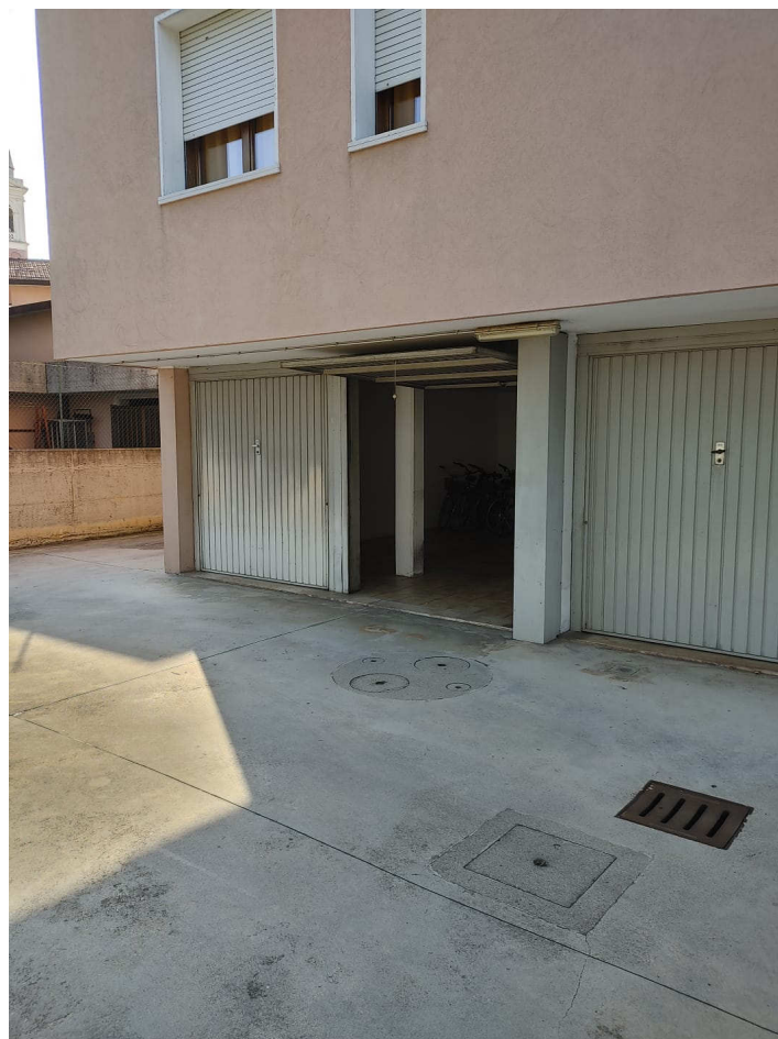
Foto 4 – vista entrata garage
