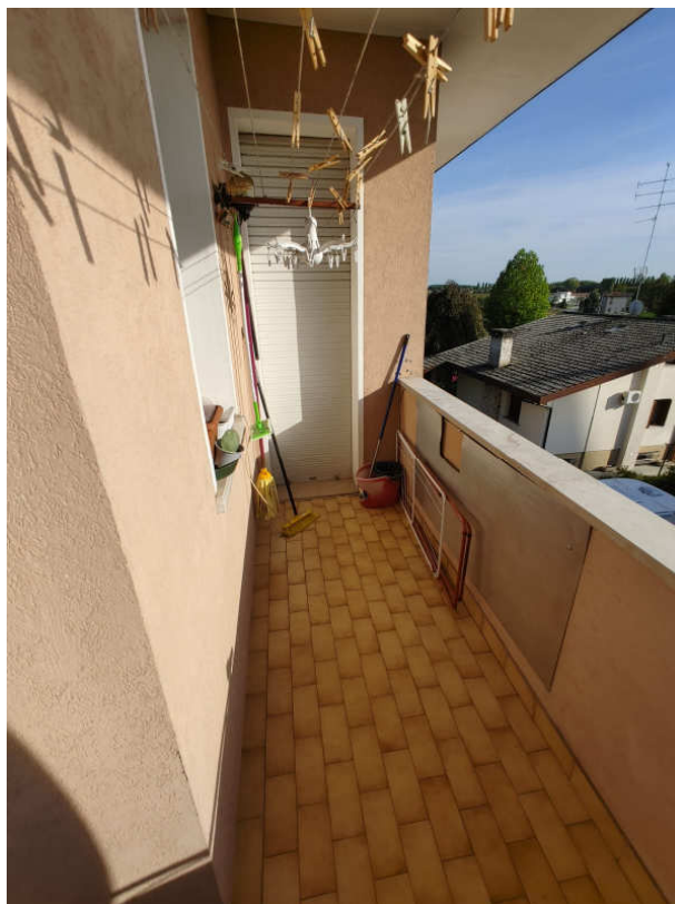
Foto 15 – vista terrazzo lato ovest
