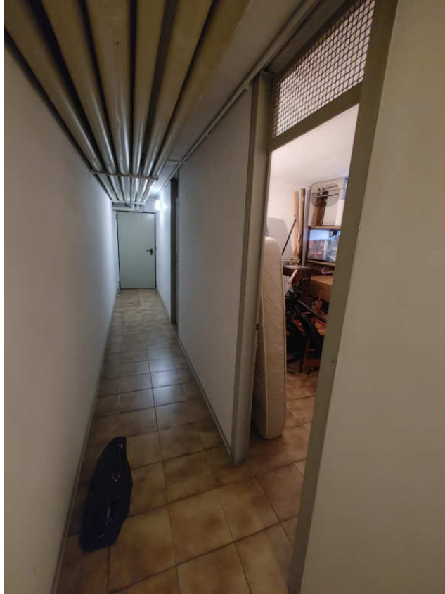
Foto 22 – vista corridoio cantine
