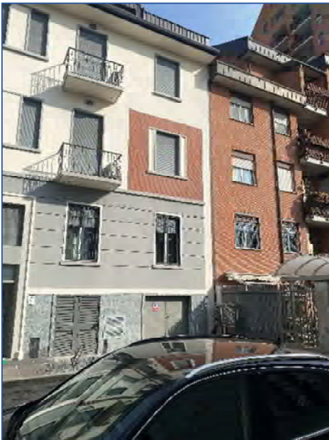
Foto 3 – immobile di via Imola n. 17
