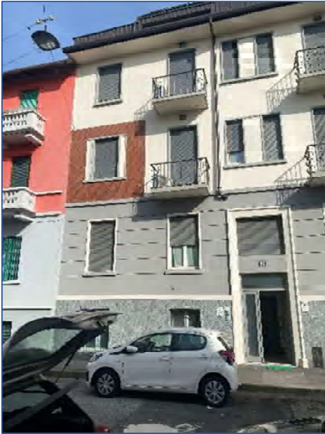
Foto 1 – immobile di via Imola n. 17
