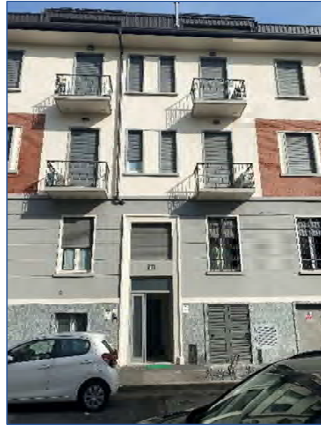
Foto 2 – immobile di via Imola n. 17
