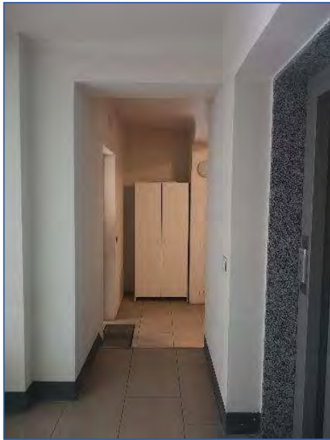
Foto 9 – spazi comuni piano seminterrato
