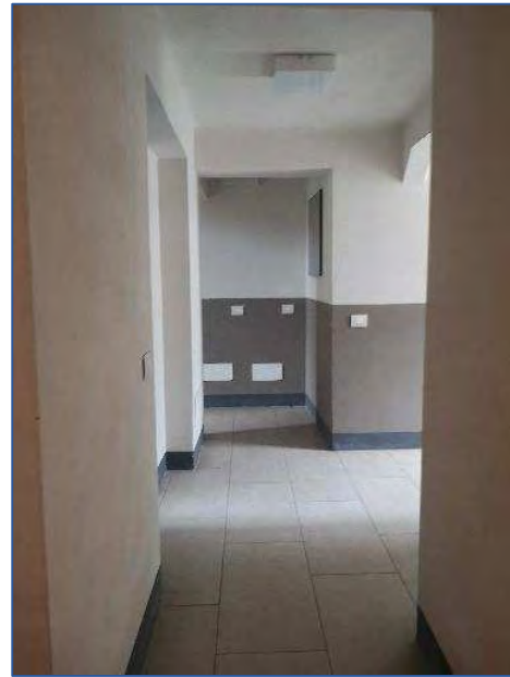
Foto 8 – spazi comuni piano seminterrato
