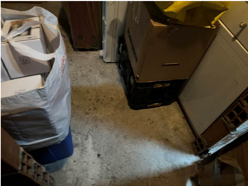
Fotografia n. 26 – Vista dell'interno del vano di solaio oggetto della procedura, con particolare della pavimentazione
