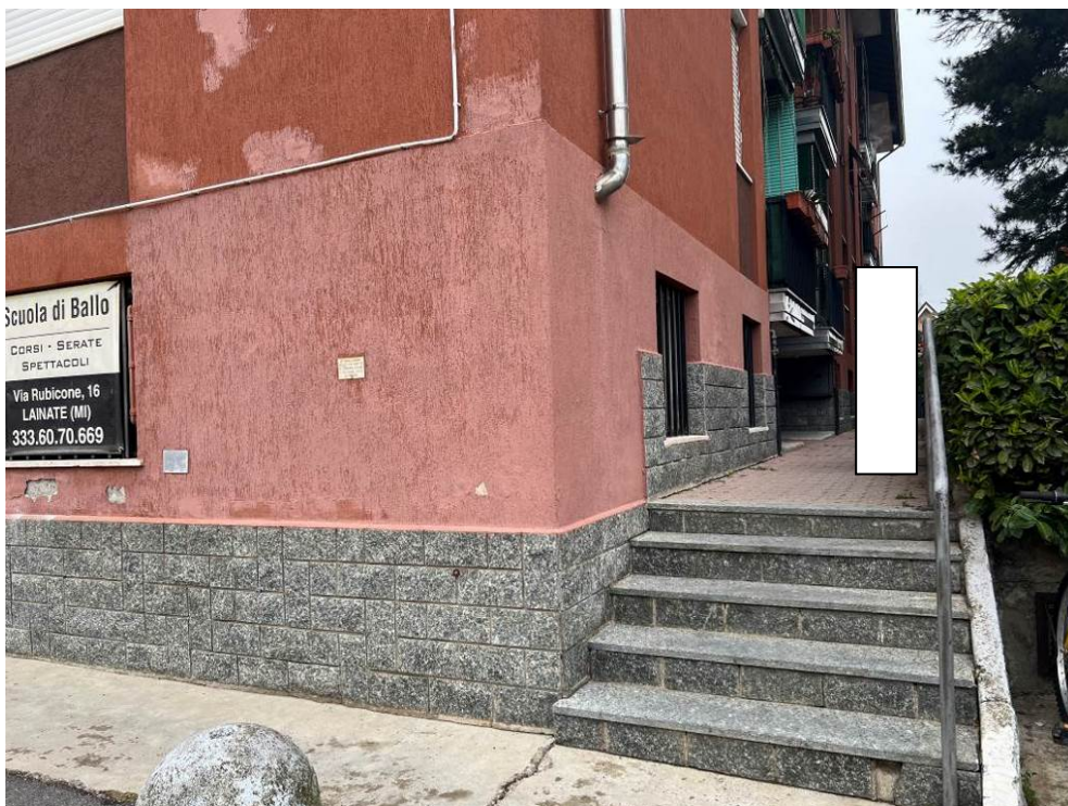
Fotografia n. 3 – Vista della rampa di scale comune che conduce all’ingresso dell’edificio al civico n. 14 di Via Rubicone
