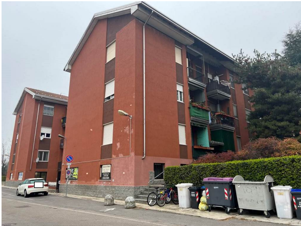
Fotografia n. 1 – Vista delle facciate principale e laterale dell'edificio del "Condominio Rubicone 14/16", dove si trova l'immobile oggetto della procedura al piano primo
