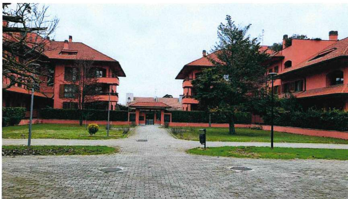
Ingresso pedonale del complesso edilizio
