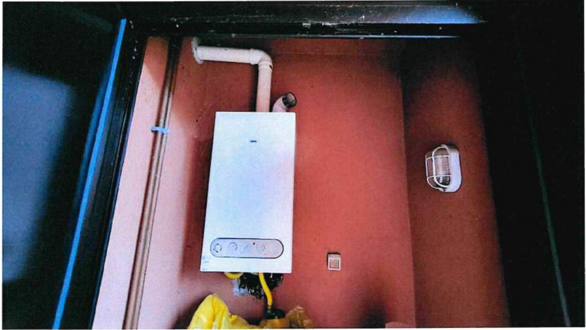
Caldia autonoma per riscaldamento e produzione ACS
