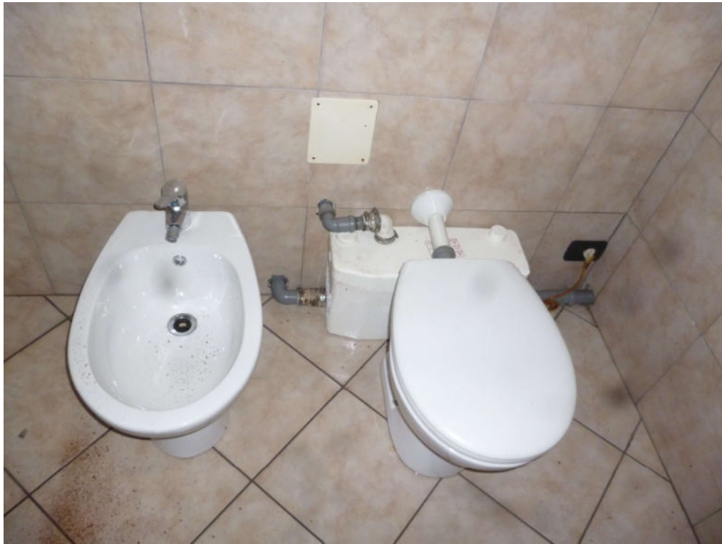
FOTO 19 – Locali cantina piano S1, particolare vano bagno
