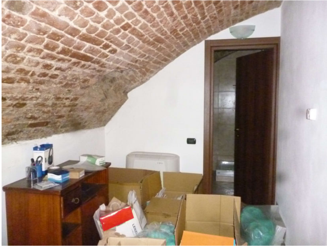
FOTO 17 – Locali cantina piano S1
