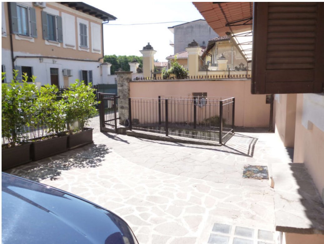
FOTO 3 e 4 – Particella 222: vista da passaggio comune e vista da Particella 221 della Particella 222 con scala di accesso all'unità sottostante (Particella 225)
