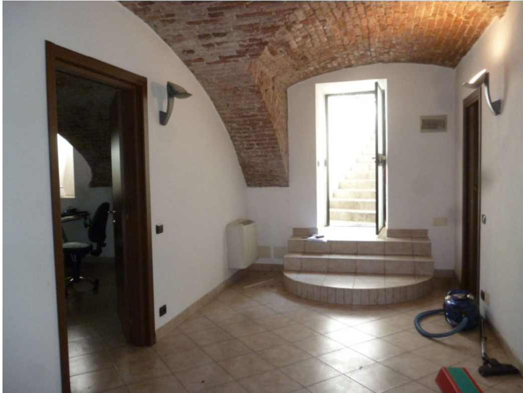
FOTO 15 – Locali cantina piano S1
