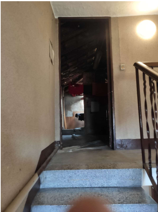
Foto n. 11 – Ingresso al sottotetto
