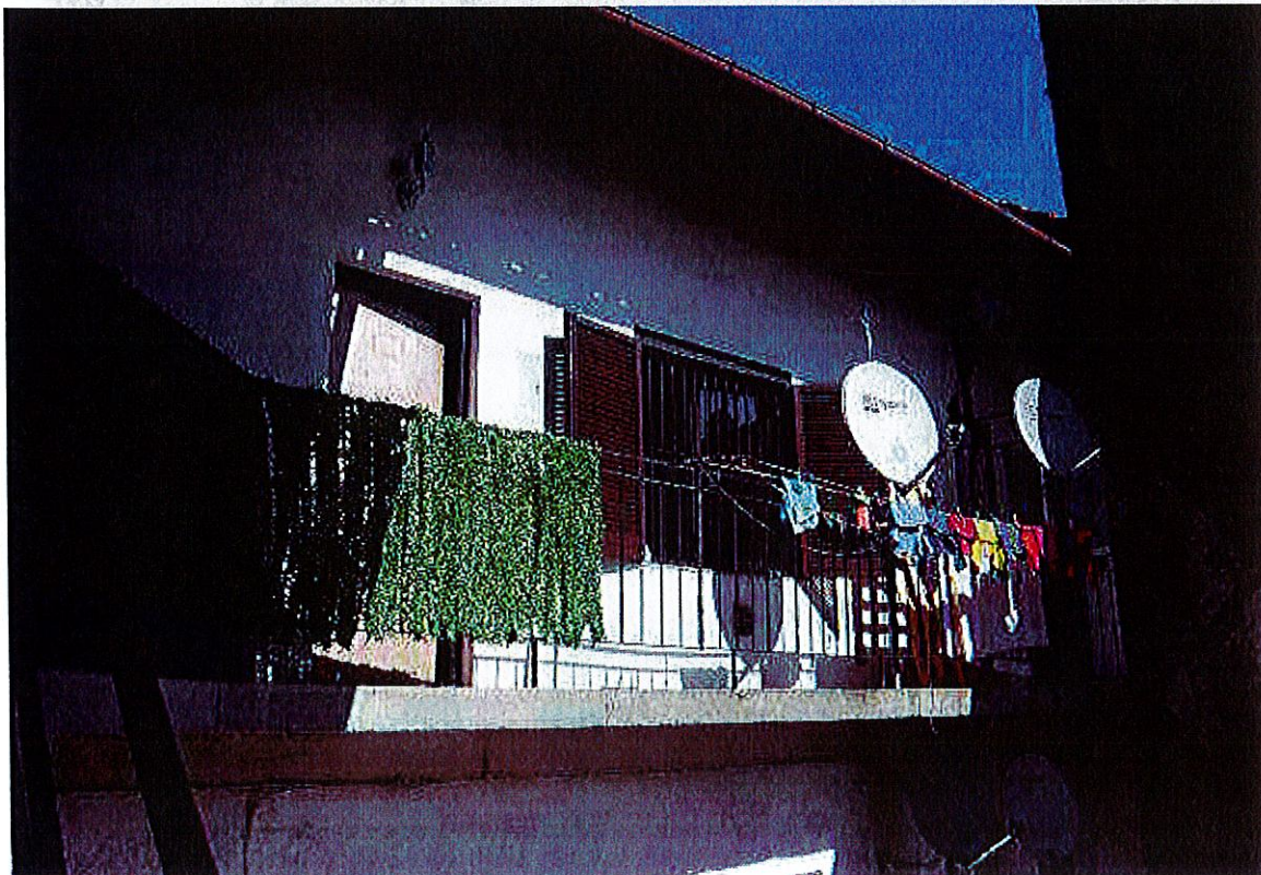
Foto 2: ballatoio comune d'accesso all'immobile
