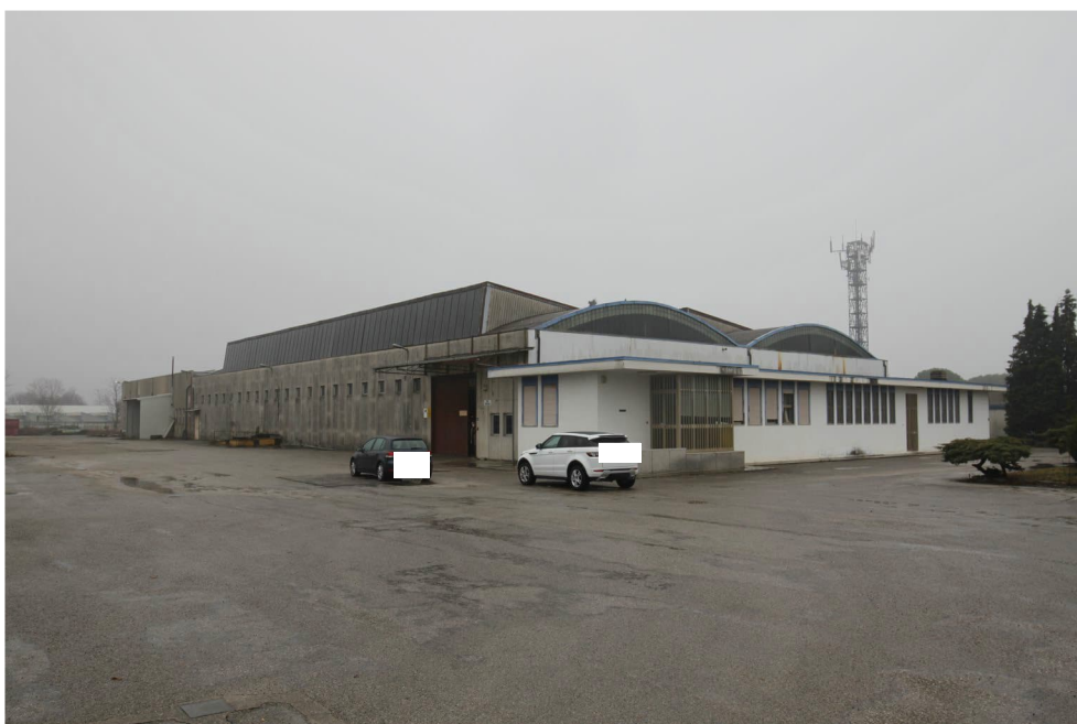
4. Foto: vista dell'immobile
