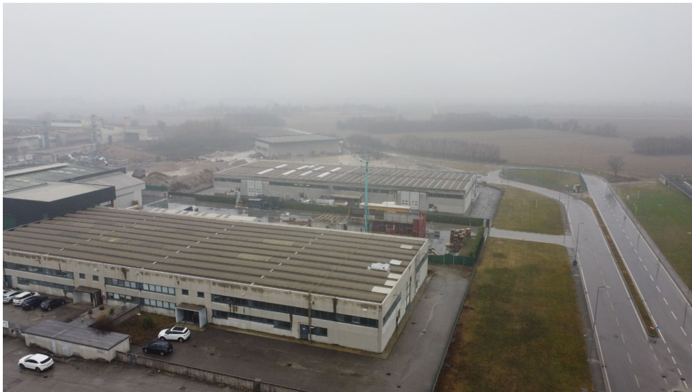
4. Foto Drone: vista dell'immobile
