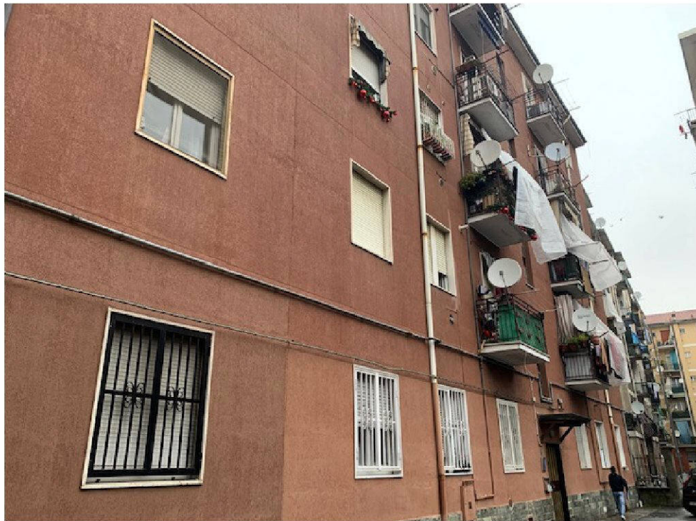
FOTO ESTERNA – EDIFICIO DI RIFERIMENTO
