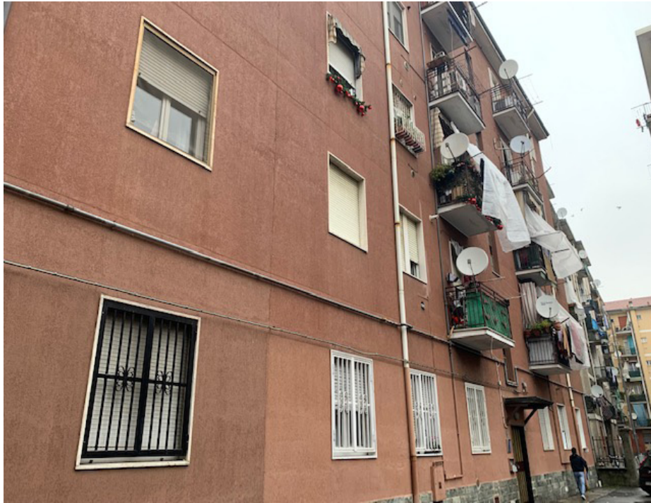
Vista esterna - fabbricato di riferimento fronte strada
