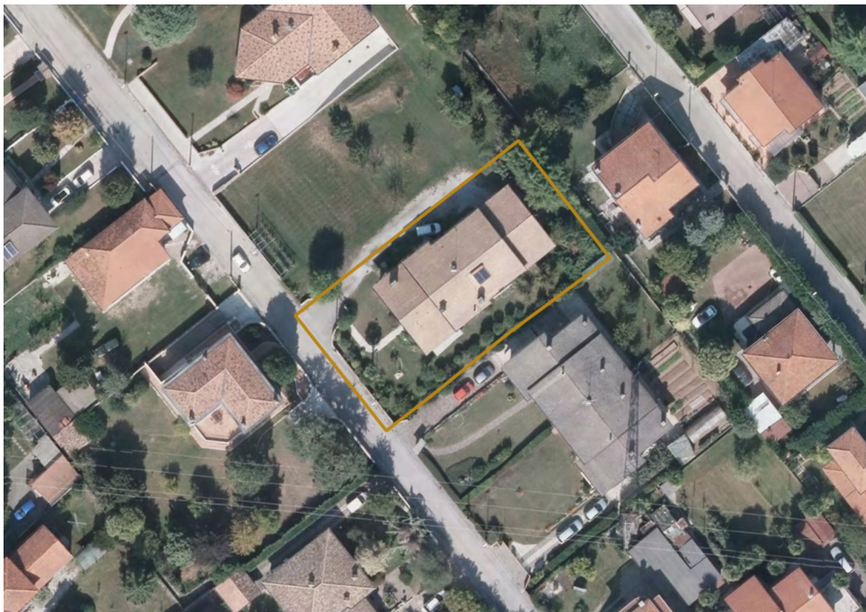
2. Ortofoto: localizzazione dell'edificio – Aerofoto particolare
