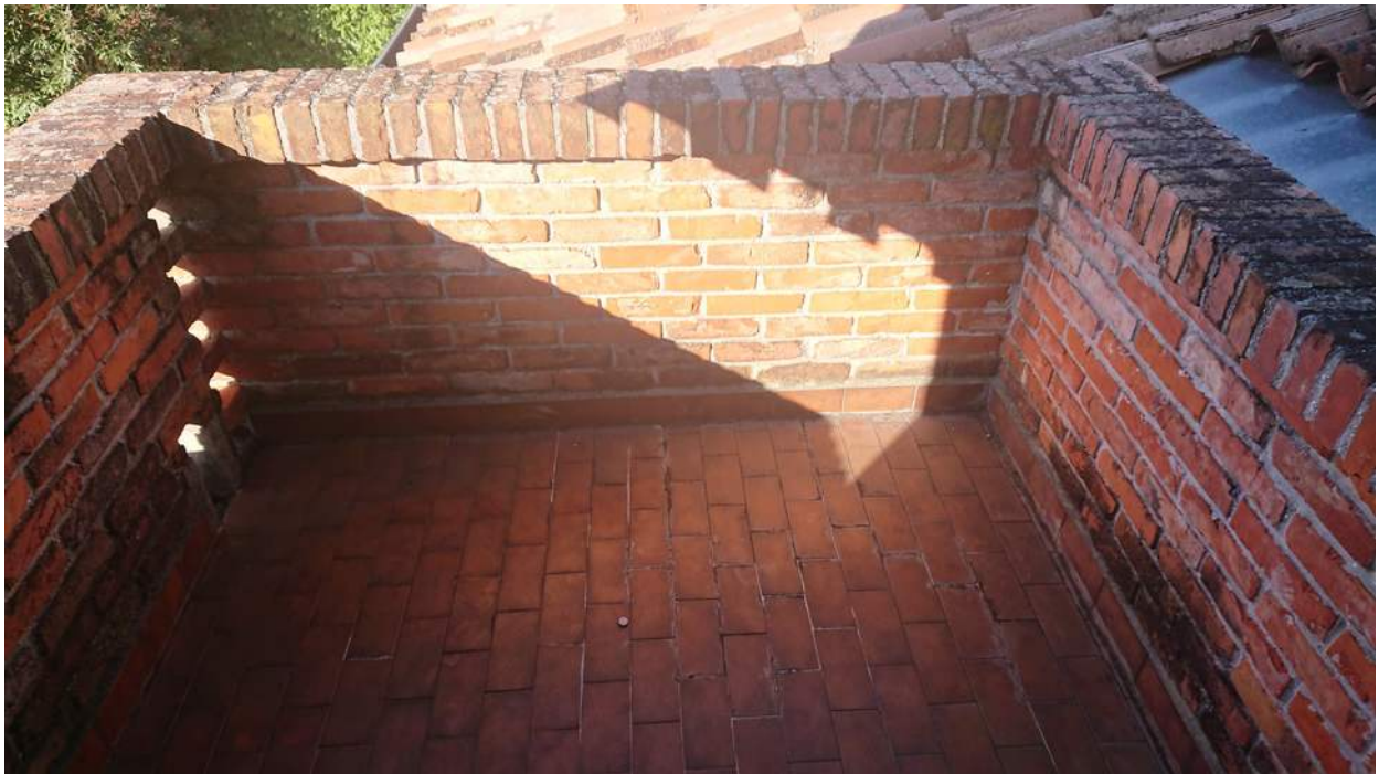
Foto n° 23 - 23/11/2021 - Comune di S.Stino di Livenza, foglio 13, part.432, sub.2 – Poggiolo, lato ovest.
