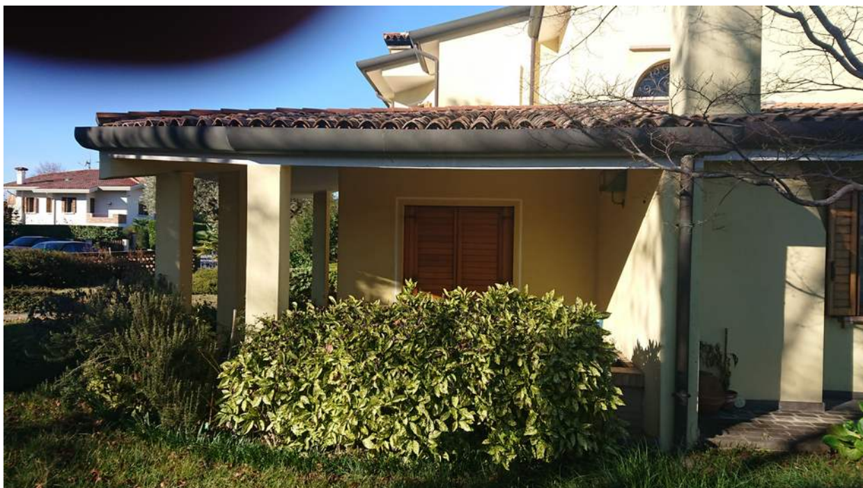
Foto n° 30 - 23/11/2021 - Comune di S.Stino di Livenza, foglio 13, part.432, sub.2 – Portico esterno.
