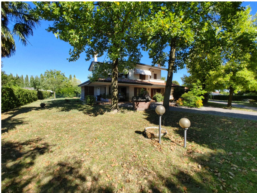
Foto 1 – vista lato Ovest
