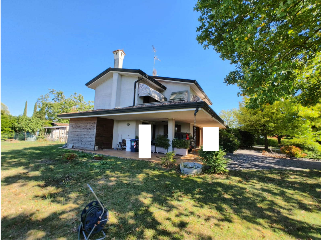
Foto 9 – Vista Nord - Ovest
