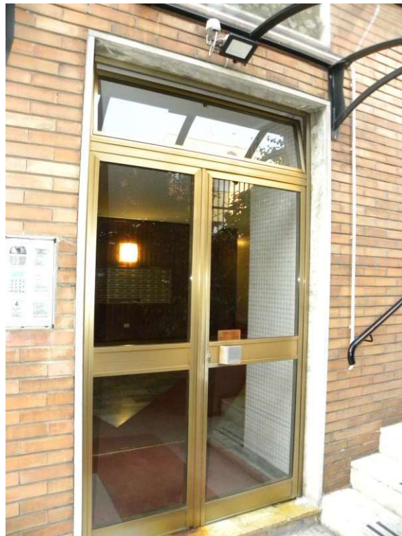
Porta di ingresso al vano scala – scala A
