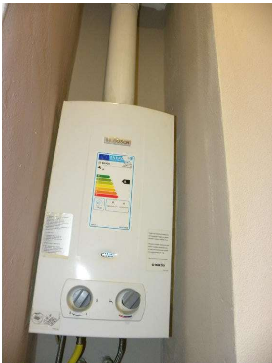
Particolare – caldaia per ACS e porte interne
