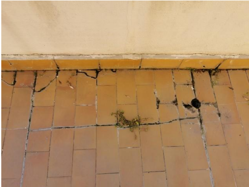
FOTO 23: PARTICOLARE PAVIMENTO TERRAZZO (Subalterno n. 5 – 1°P.)
