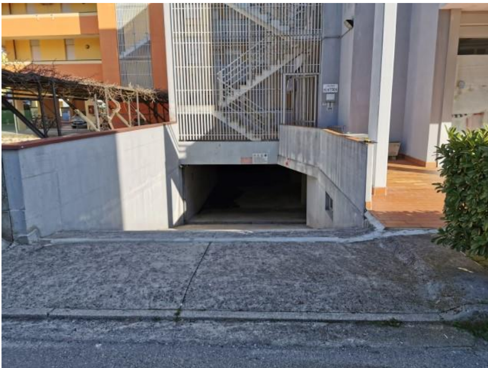
FOTO 6: ACCESSO CARRAIO AL PIANO INTERRATO DA VIA ELETTRA
