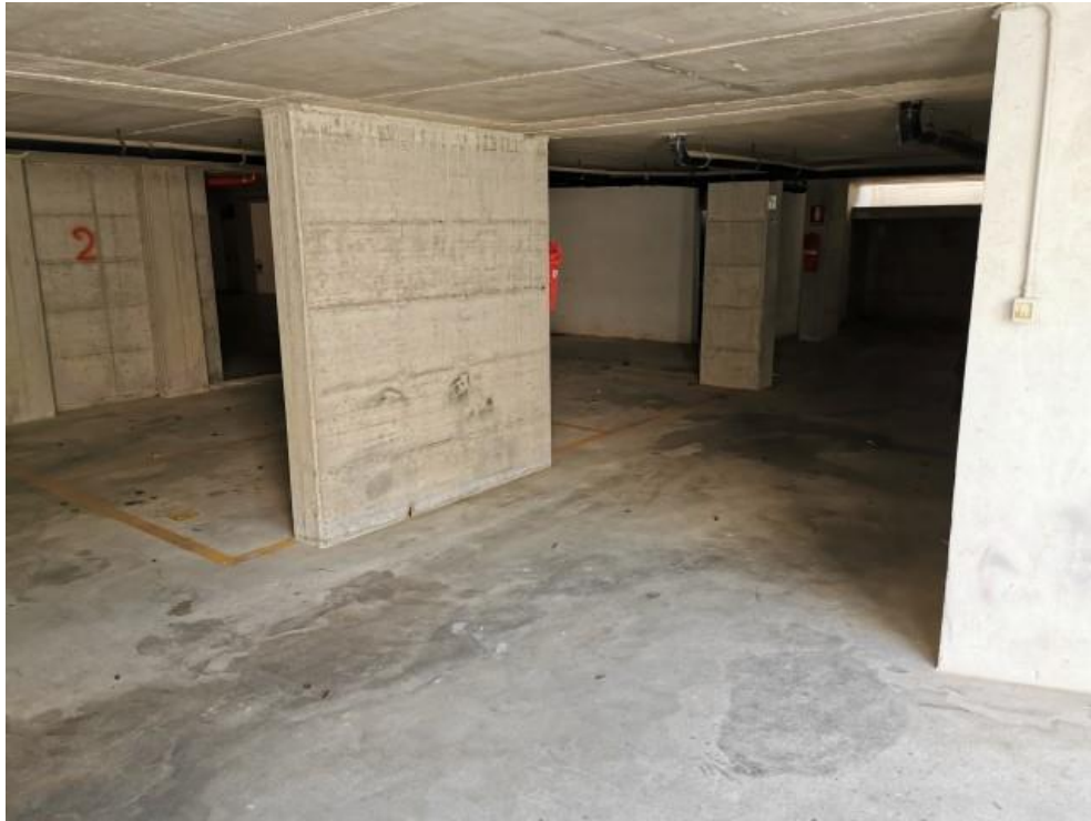
FOTO 33: PIANO INTERRATO CONDOMINIO ELETTRA
