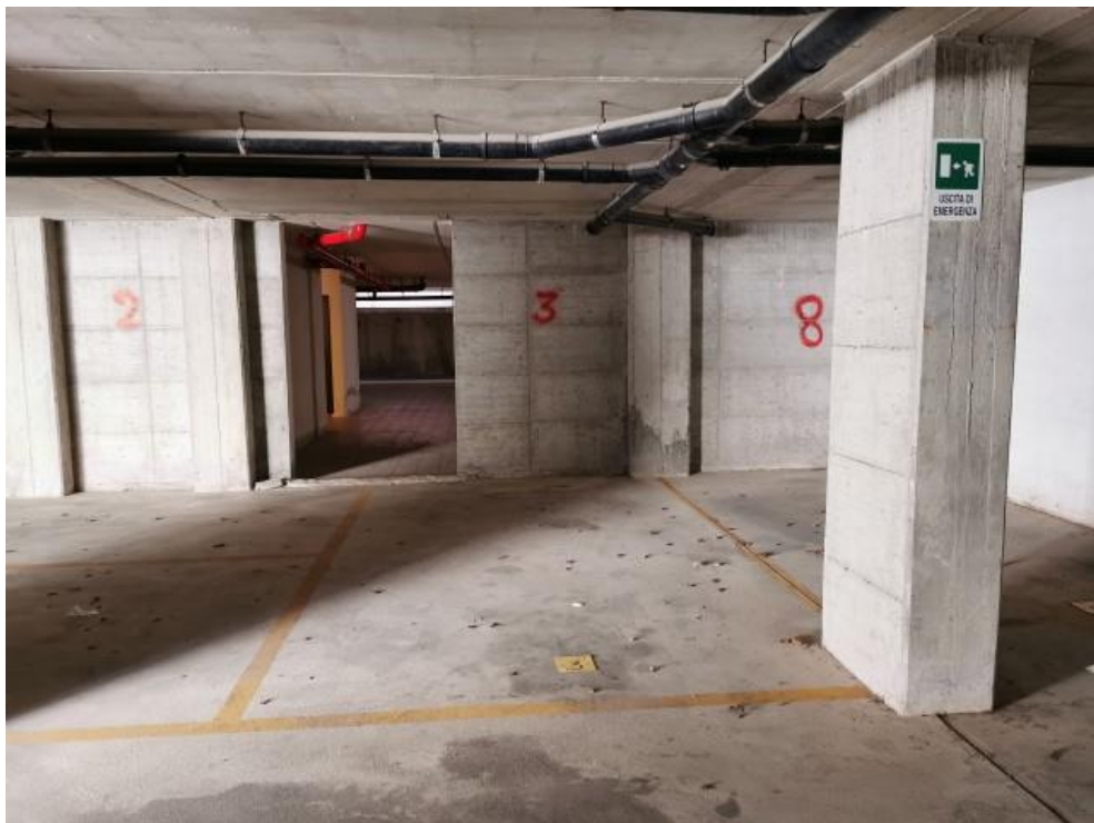
FOTO 34: POSTO AUTO AL PIANO INTERRATO – SUBALTERNO N. 14
