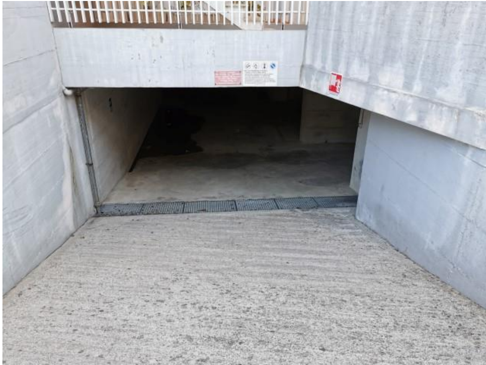
FOTO 31: RAMPA PER ACCESSO AL PIANO INTERRATO COND. ELETTRA
