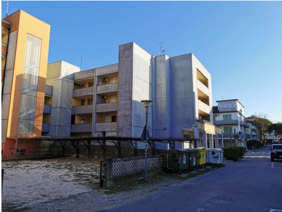
FOTO 3: ALTRA PANORAMICA CONDOMINIO ELETTRA
