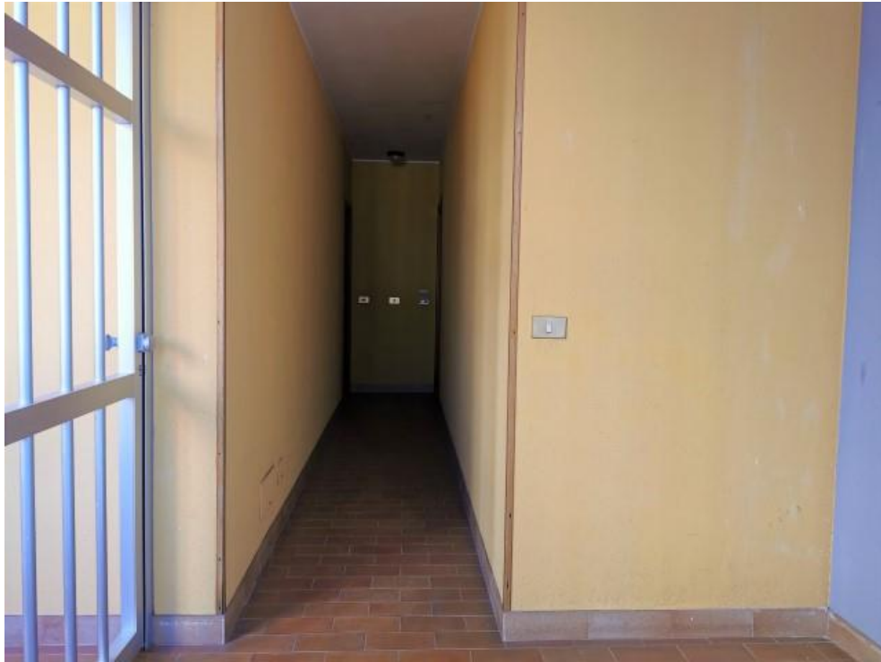
FOTO 9: DISIMPEGNO CONDOMINIALE (1°P.)
