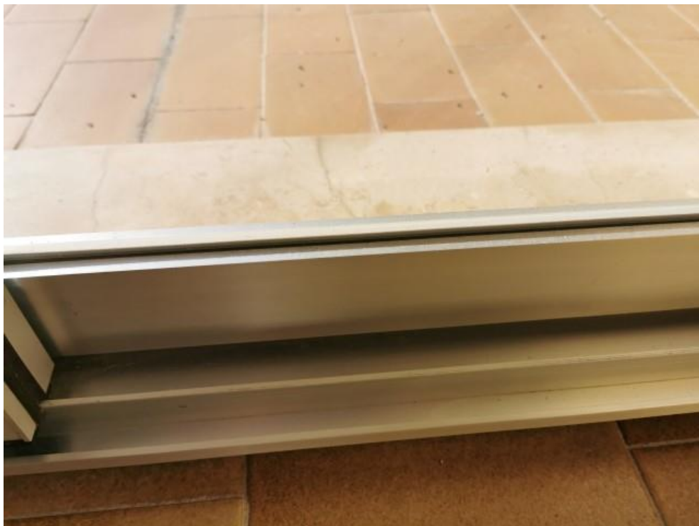
FOTO 30: PARTICOLARE SERRAMENTO (Subalterno n. 5 – 1°P.)
