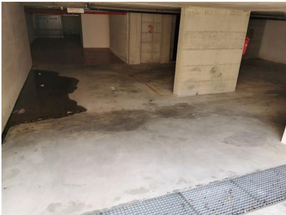
FOTO 32: PIANO INTERRATO CONDOMINIO ELETTRA
