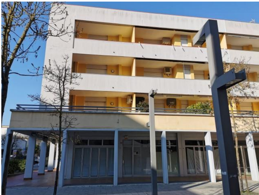
FOTO 2: ALTRA PANORAMICA CONDOMINIO ELETTRA
