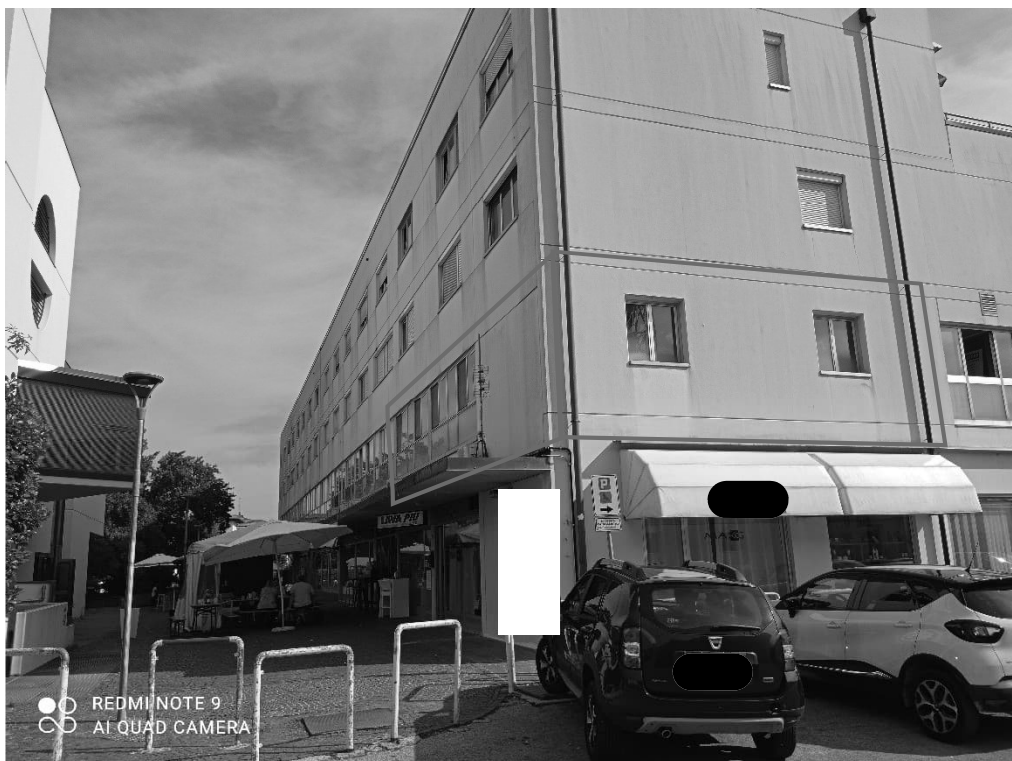
Vista angolo Nord – Ovest / Sud - Ovest
