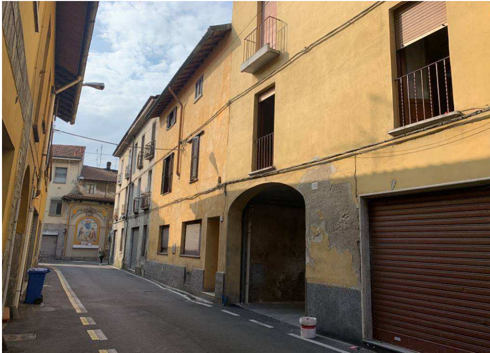
Fotografia n. 1 – Vista del prospetto principale della palazzina dove si trova l'immobile oggetto della procedura, con ingresso direttamente da Via Giuseppe Mazzini n. 24
