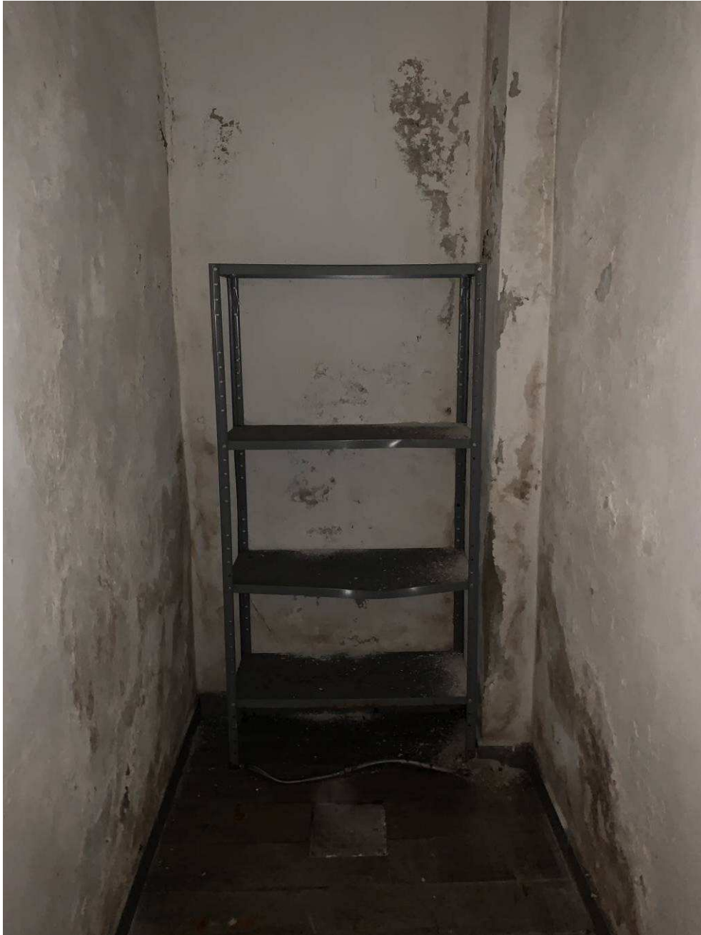
Fotografia n. 30 – Vista del vano cantina sul retro al piano interrato
