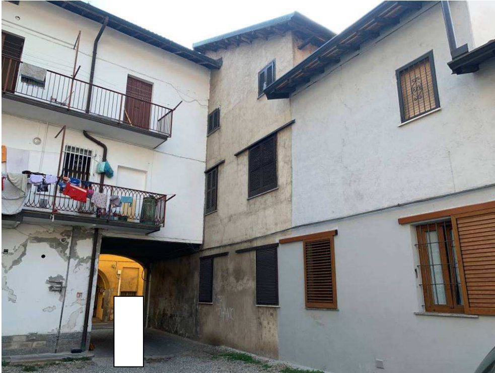
Fotografia n. 4 – Vista del cortile interno su cui affaccia il prospetto laterale dell'immobile oggetto della procedura, con accesso direttamente da Via Giuseppe Mazzini n. 24, con fossa biologica a terra
