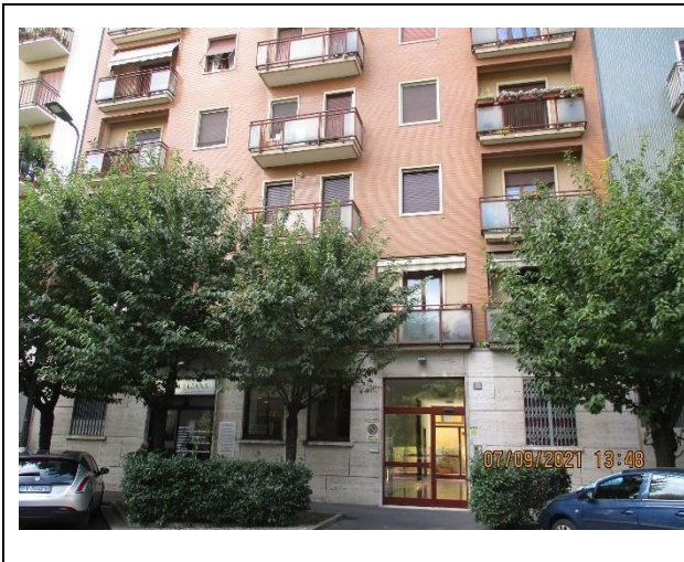
Fabbricato- facciata esterna
