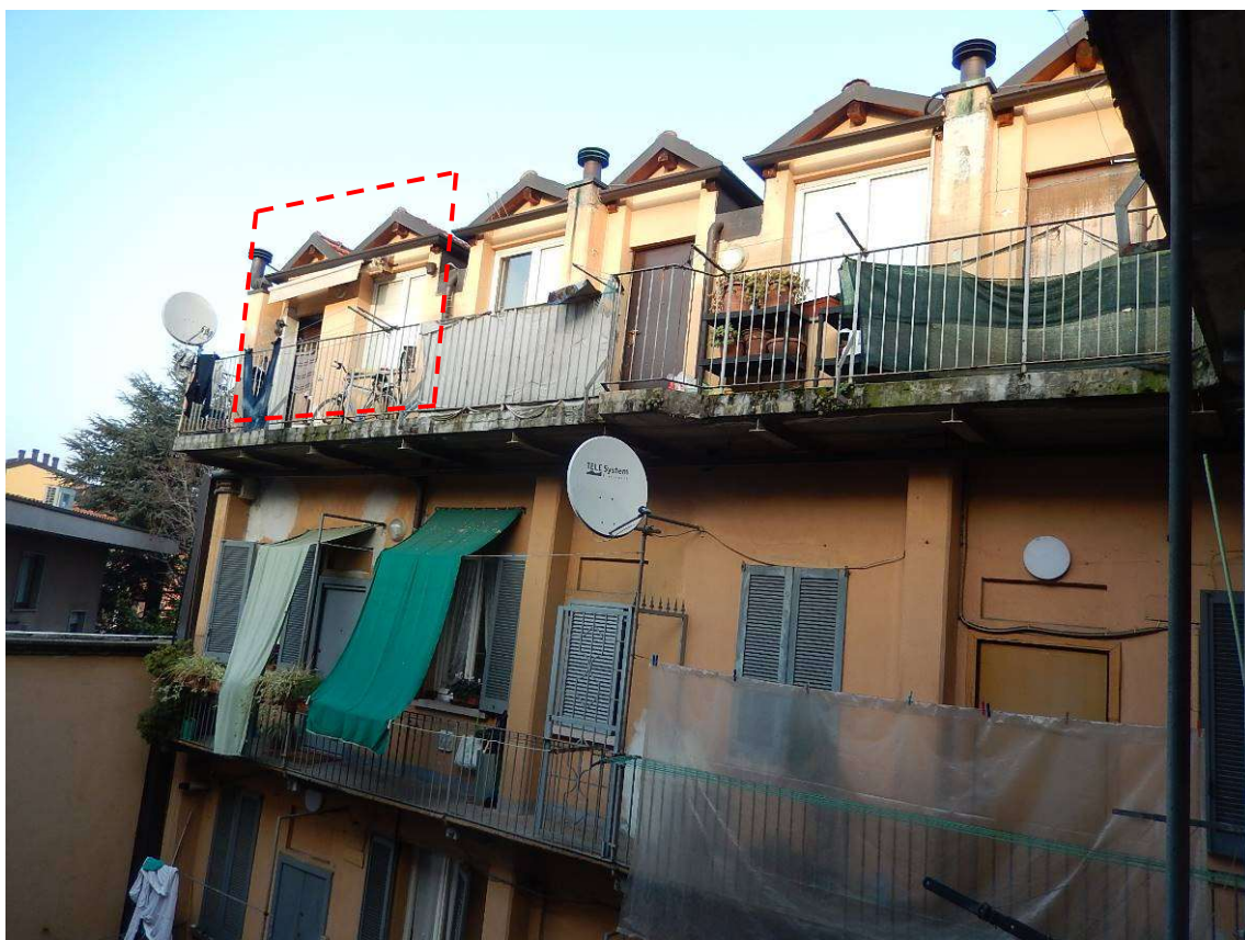
Foto 6 – Vista parziale della facciata sul cortile. Il bene in esame evidenziato dal tratteggio.
