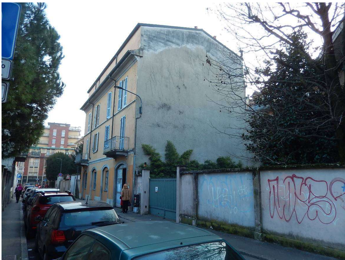
Foto 1 – Vista d'insieme dell'edificio da nord.
