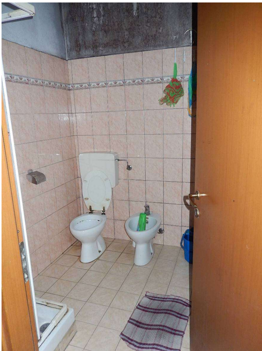
Foto 11 – Vista parziale del bagno.
