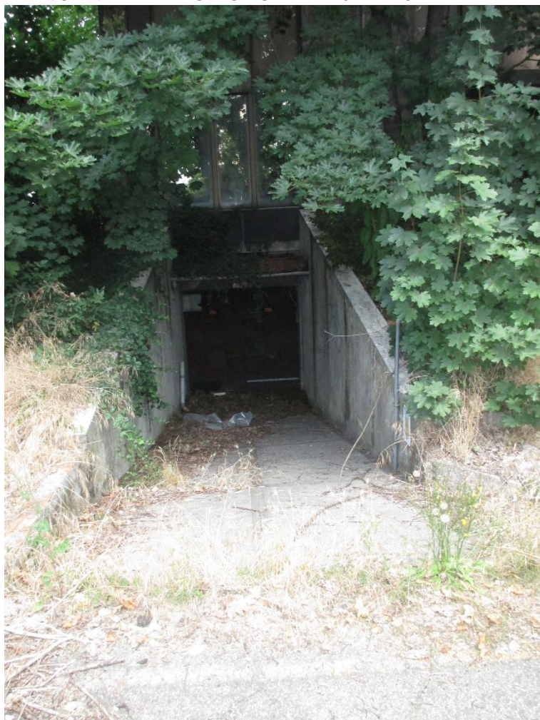
Foto 140: accesso esterno all'interrato
