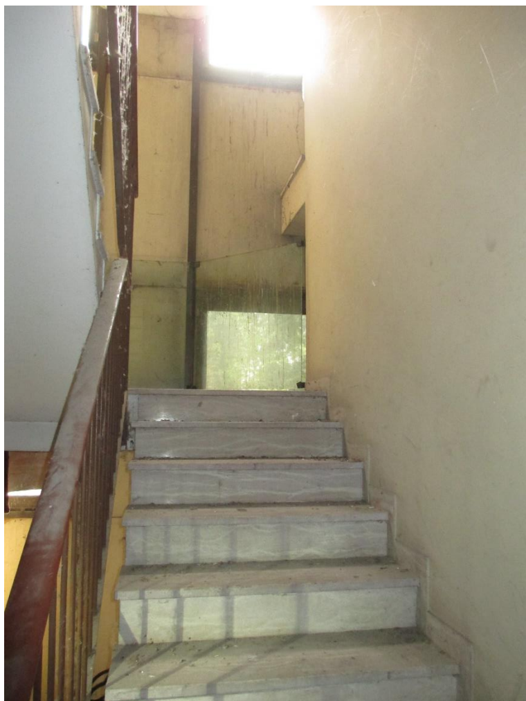
Foto 33: scala dal primo al secondo piano
