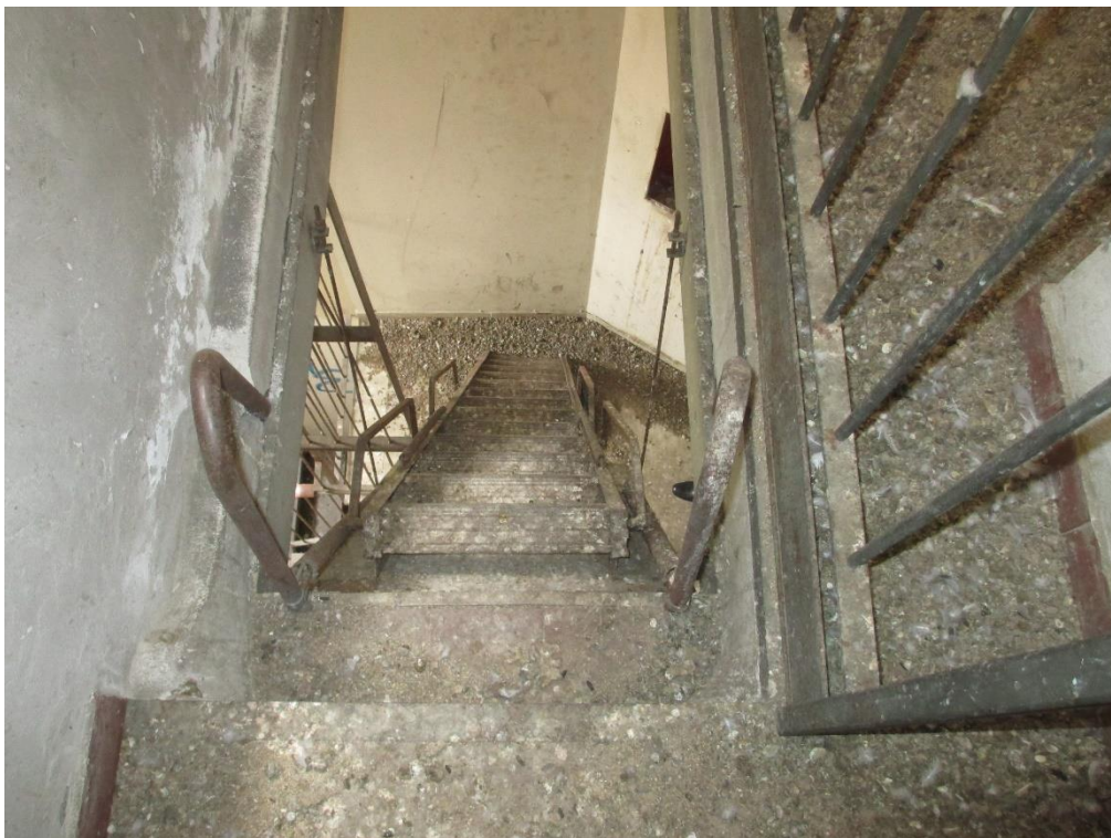
Foto 139: scala di accesso al non piano
