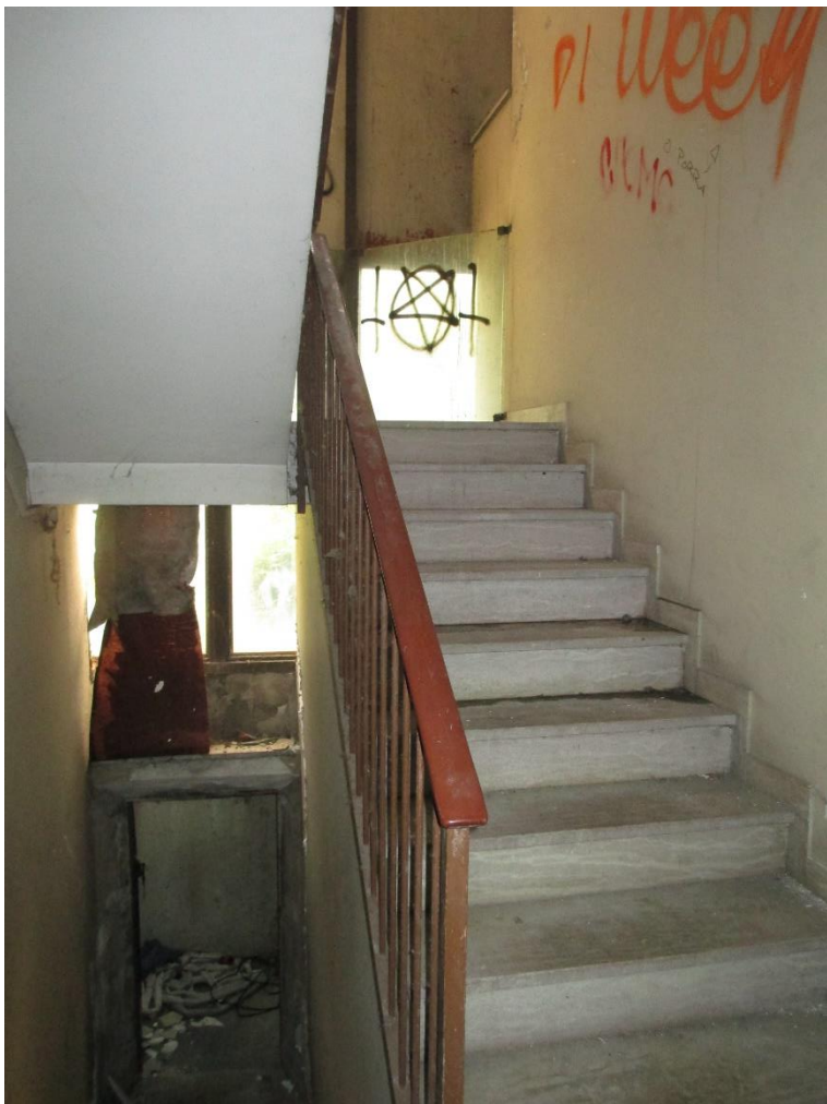
Foto 16: scala da piano terra a piano primo
