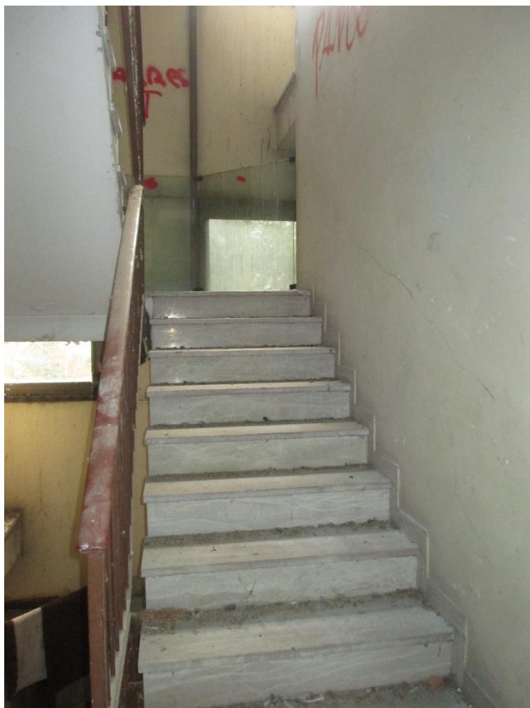
Foto 47: scala dal secondo al terzo piano
