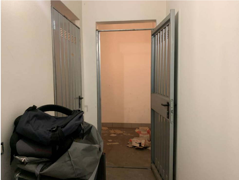
Fotografia n. 1 – Vista della porta di ingresso all'unità immobiliare F (cantina piano interrato)
