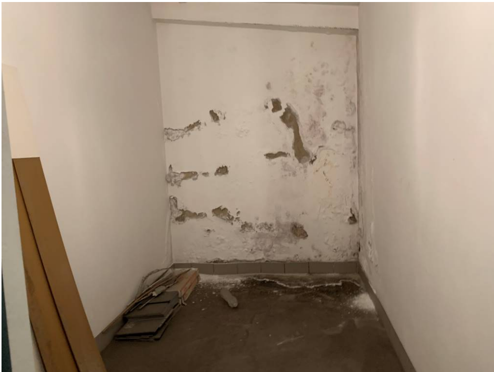
Fotografia n. 2 – Vista dell'interno dell'unità immobiliare F (cantina piano interrato)
