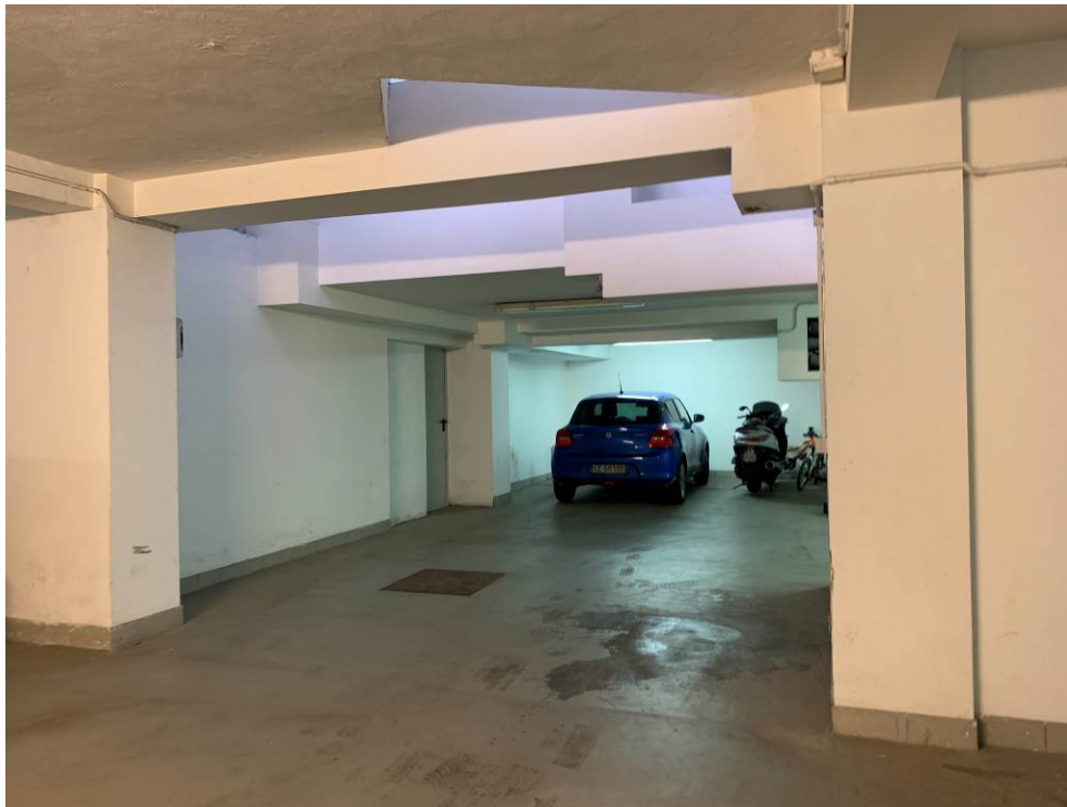
Fotografia n. 1 – Vista del corsello che conduce alle unità immobiliari G-H (posti auto piano interrato)
