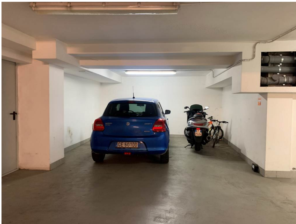
Fotografia n. 2 – Vista delle unità immobiliari G-H (posti auto piano interrato)
