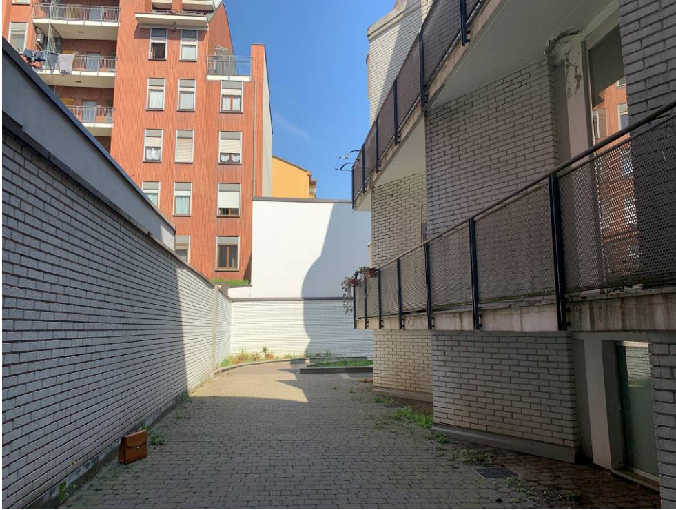
Fotografia n. 23 – Vista del balcone del piano primo ad ufficio
