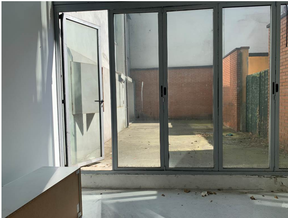
Fotografia n. 19 – Particolare della vetrata dello spazio espositivo polifunzionale, che affaccia sul cortile di proprietà
