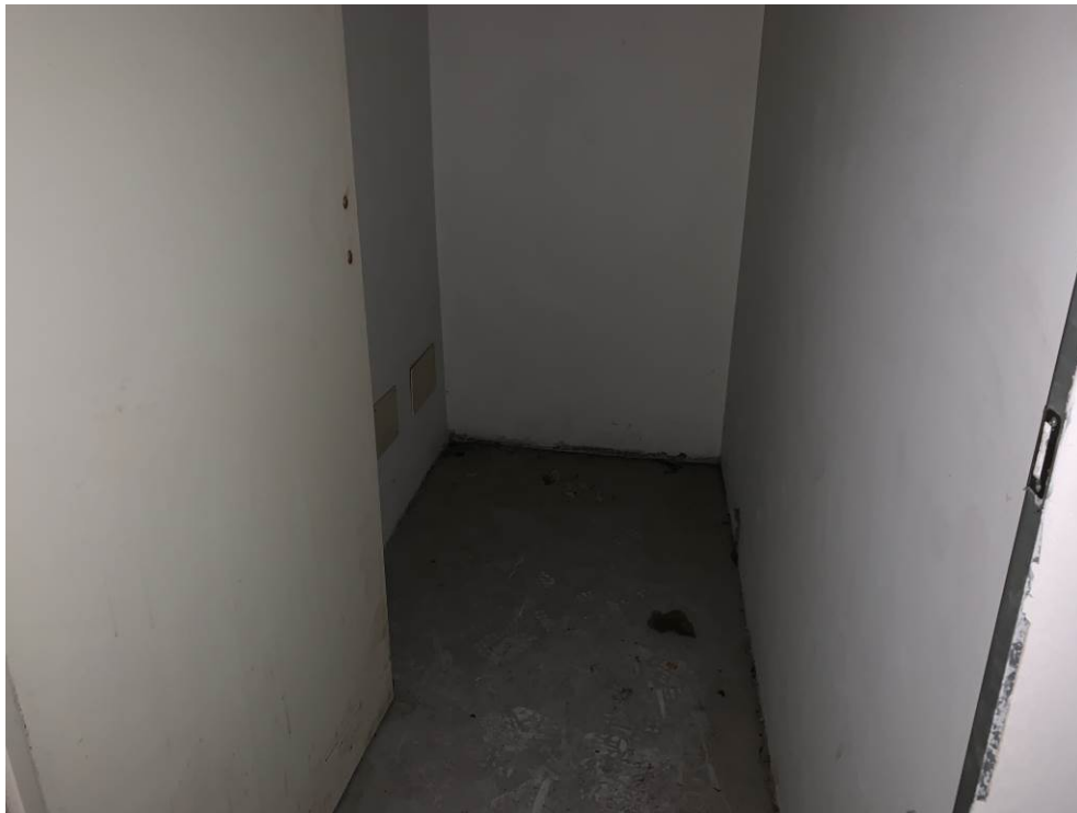
Fotografia n. 38 – Locale deposito s.p.p.
