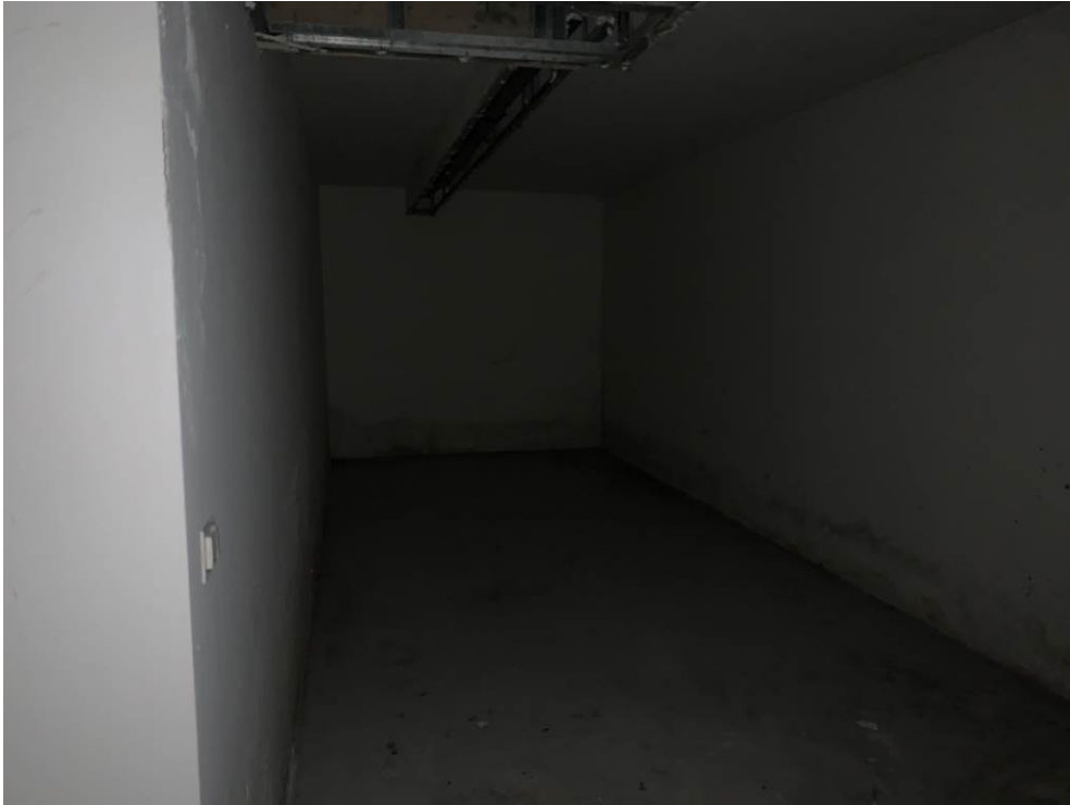
Fotografia n. 35 – Locale deposito s.p.p.
