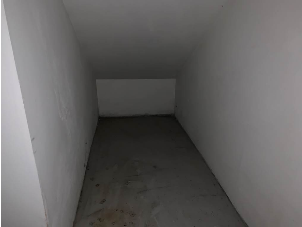
Fotografia n. 39 – Area a deposito s.p.p., in prossimità della scala che conduce al piano terra
