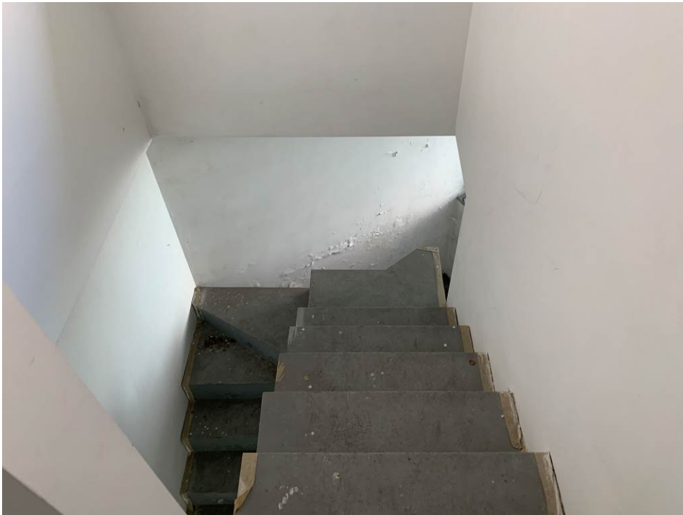
Fotografia n. 24 – Vano scala (con finestra) che conduce al piano primo
